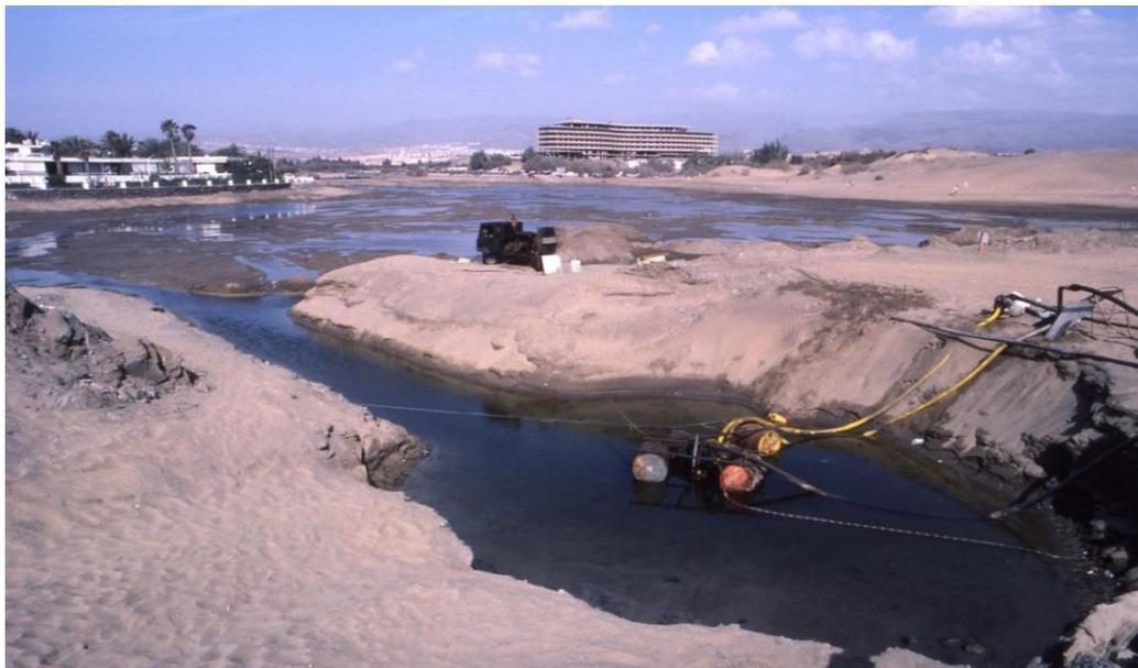
Fotografía 3.10: panorámica de las intervenciones en la Charca de Maspalomas, en 1987, para el saneamiento de sus arenas del fondo y de los laterales
