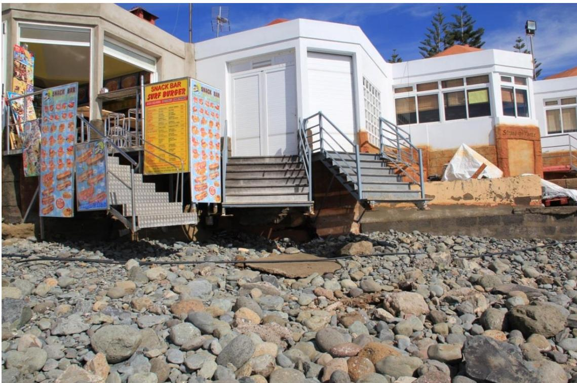
Fotografía 3.29: afectación de la erosión de los temporales del S-W a la fachada marítima del Centro Comercial Oasis (20 de febrero de 2011)
