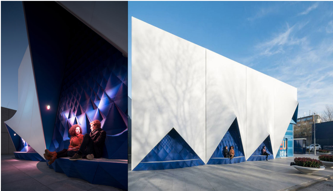
Figura 51. Fachada edificio Europa en Ámsterdam [7]
