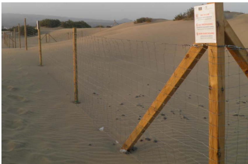
Figura 233: Vista parcial del vallado finalizado.
