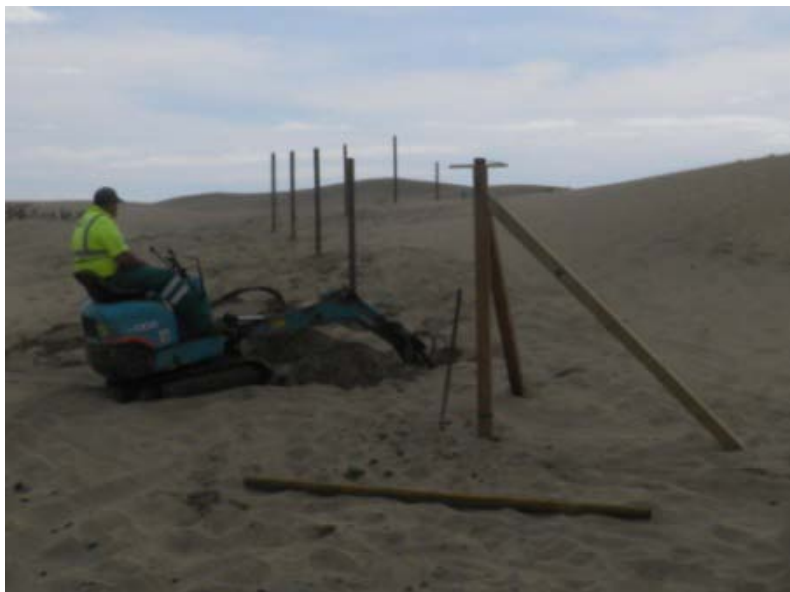
Figura 232: Realización de las primeras tareas, en la ejecución del vallado.
