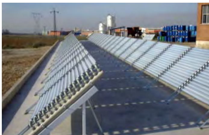
Figura 1.21. Planta experimental industrial de Fotocátalisis Solar (Arganda del Rey, Madrid). Fuente: Plataforma Solar de Almería, PSA-CIEMAT.
