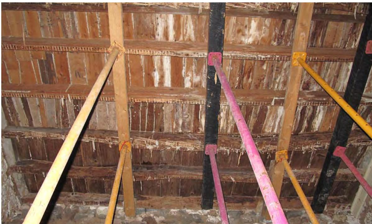
*Figura VII.12. Cubierta apuntalada debido al débil estado de conservación en el que se encuentran de algunas de las vigas sostén del entramado de madera (Procedencia gráfica: Díaz, I.).*
