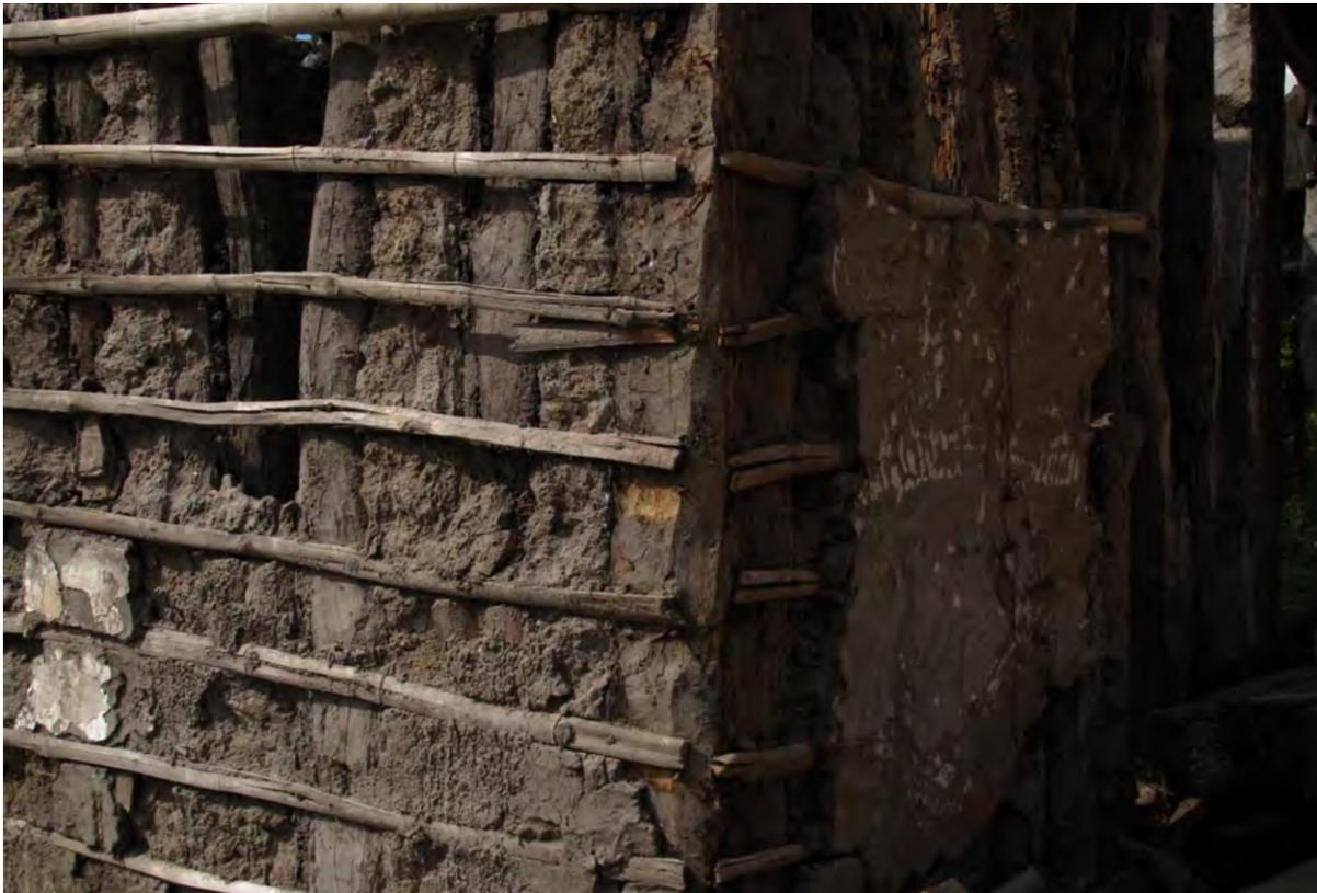
*Figura 17. Horcones sobre los que se apoyan la estructura horizontal de esta vivienda, rellena de barro y fibras vegetales en la técnica constructiva del estanco (Procedencia gráfica: Díaz, I.).*
