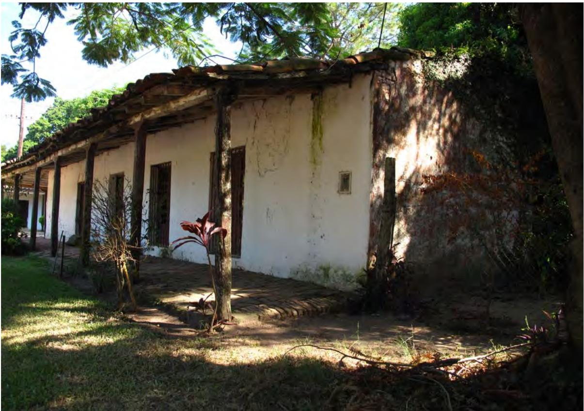
*Figura 15. Alero pronunciado para la evacuación de lluvias y generación de sombras. Se aprecia en los muros de la vivienda la proliferación de hongos y algas debido a la elevada proporción de humedad ambiente (Procedencia gráfica: Díaz, I.).*
