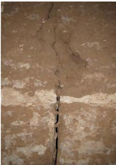
Por otro lado, la zona del muro más próxima a la ventana exterior es la que se encuentra en peor estado debido a un proceso degradativo natural, presentando una decohesión superficial de la tapia, en la que la disminución de la unión y adhesión de los granulos que conforman el sistema constructivo ha producido un debilitamiento de sus características mecánicas originales (*Figura VII.15*).
