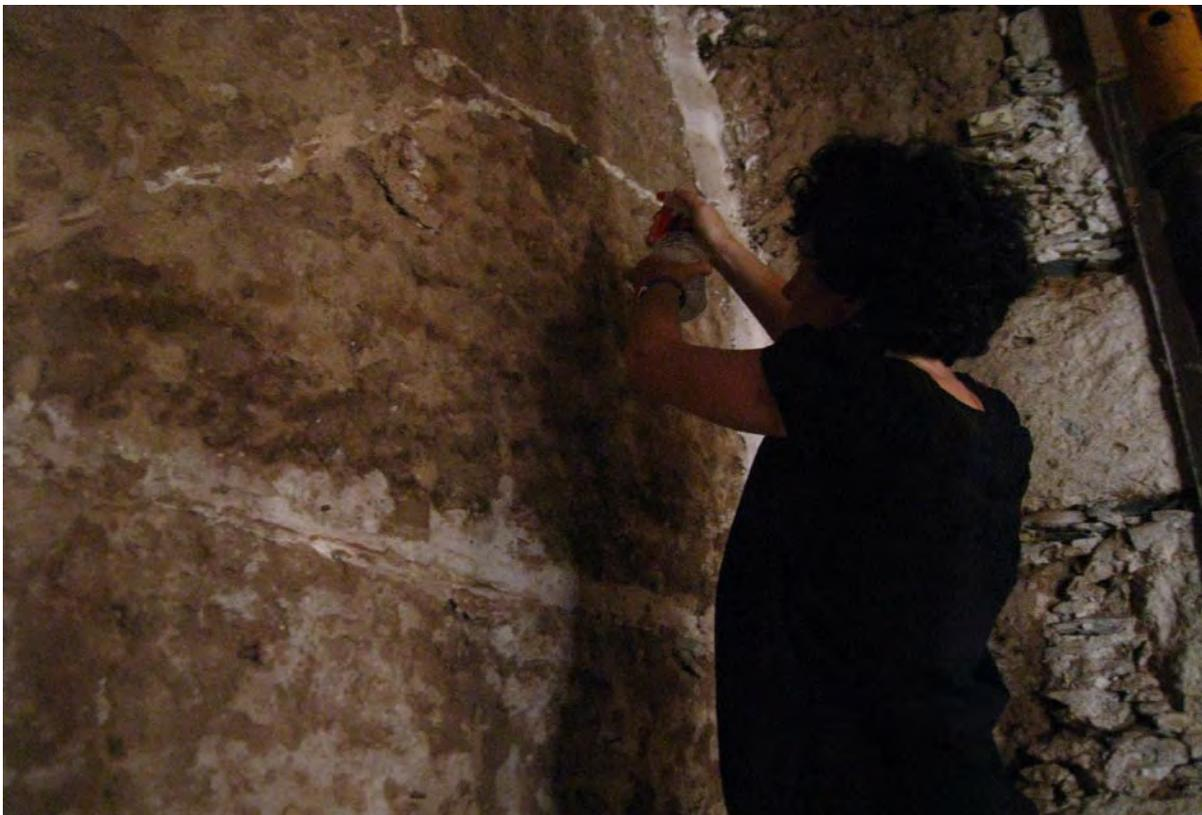
*Figura VII.17. Proceso de consolidación del muro. (Procedencia gráfica: Díaz, I.).*
