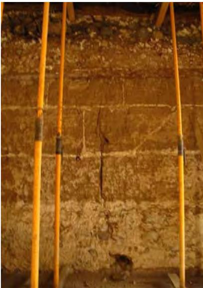
Se localiza justo en el punto de unión de dos cajones situados en primera hilada (7 y 8). La fisura se produce por una pérdida de argamasa con la consecuente desaparición de la junta de cal que un día uniese los dos mampuestos, generándose en esta zona un quiebre.
