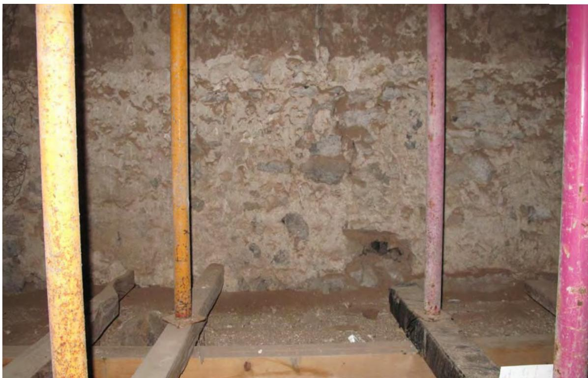
*Figura VII. 7. Zócalo realizado con piedras de diferente tamaño y mortero de cal. (Procedencia gráfica: Díaz, I.).*
