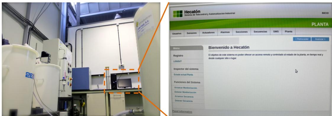
**Figura 25.** Vista del ordenador conectado al sistema automatizado de control de la planta y detalle del software Hecatón [Elaboración propia].
