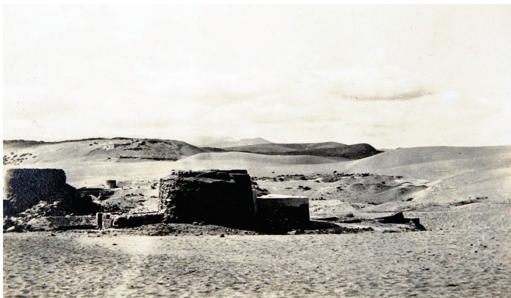
Fig. 4.1. Hornos de cal en los arenales de Santa Catalina (Las Palmas de Gran Canaria). (1920-1930). Fuente: FEDAC, Archivo de Fotografía Histórica de Canarias. Autor: Colección José A. Pérez Cruz).
