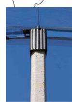
Estructura principal para la sujeción de las telas. Postes de hormigón con capuchón para el cruce de alambres
