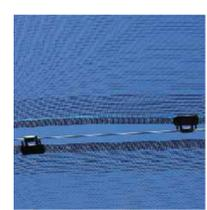
Se trata de la estructura secundaria para la sujeción de las telas. Se trata de alambres, que apoyan en la estructura principal y con la ayuda de clips (Anclorpack), agarran las telas.
