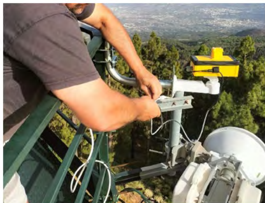
Figura 15. Montaje del visor en la torre de vigilancia de El Gaitero (Tenerife).
