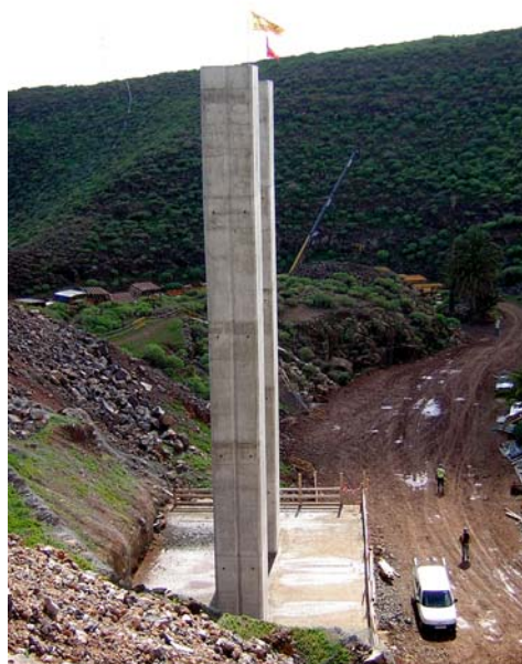
Foto 2. Sedimentos aluviales de consistencia floja excavados en el fondo del cauce. En primer término, cimentación y pilas del vano central.
