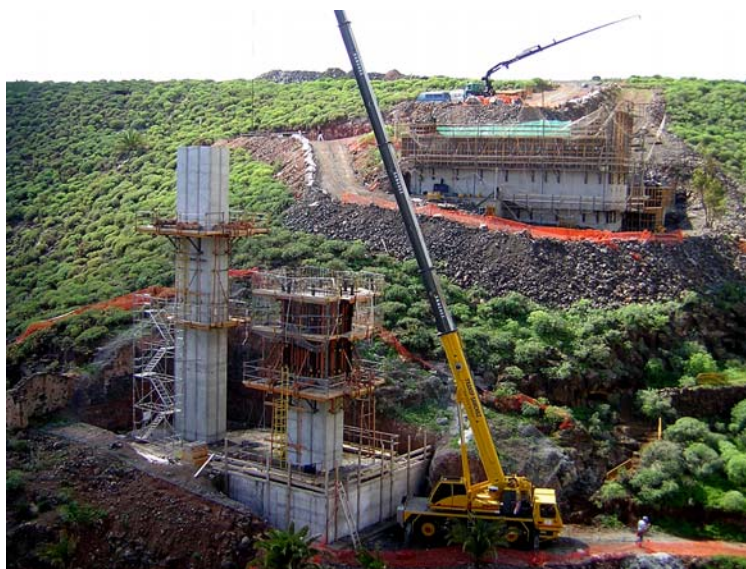
Foto 1. Depósitos aluviales antiguos de origen volcánico sobre las laderas del Barranco de Aromeros. Viaducto en construcción en la autovía de circunvalación Carrizal-Ingenio-Agüimes (Isla de Gran Canaria).
