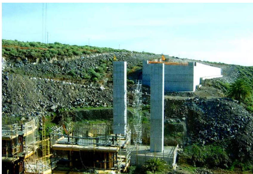
Foto 4. Situación de la ladera antes de la excavación de las cimentaciones de la cimbra, donde pueden apreciarse los rellenos superficiales realizados durante las obras y los bancales de cultivo.
