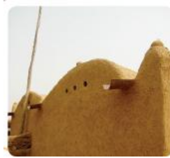
Figura 4.12: Acabado con canaletas
