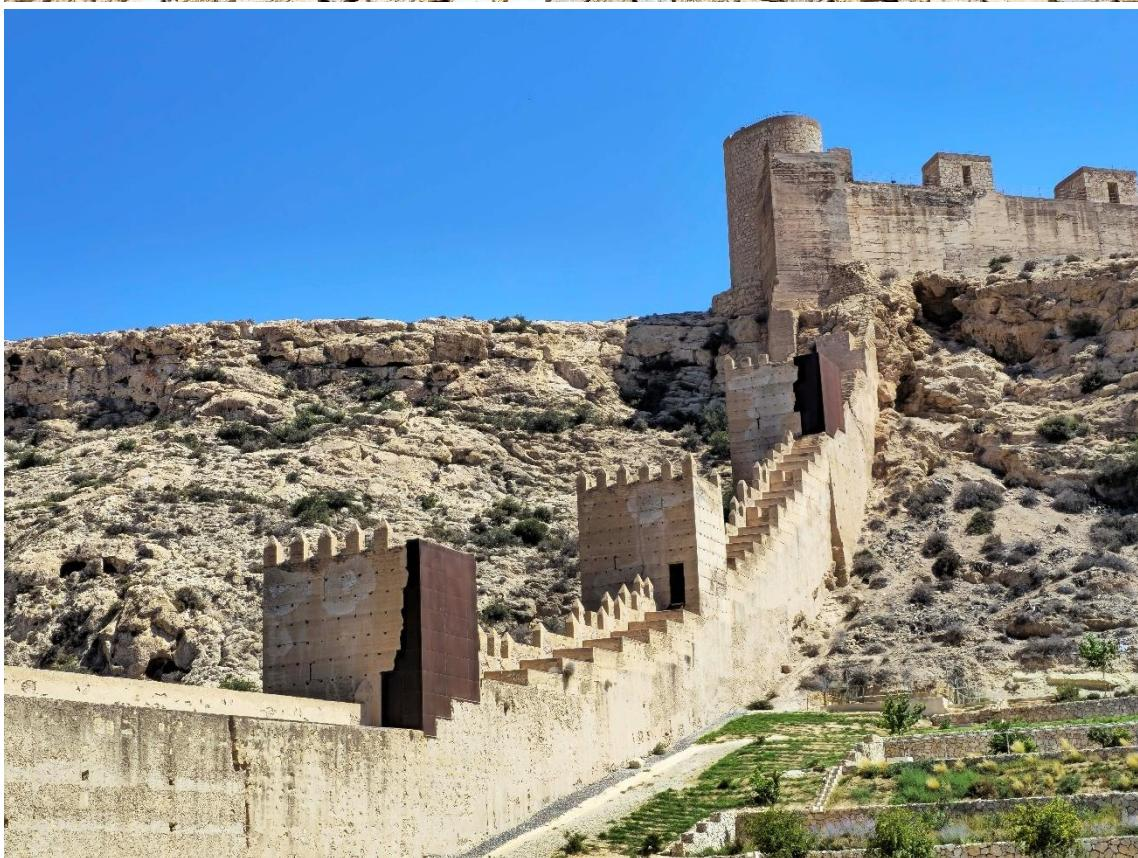
Fotografías 7.39 y 7.40: vistas de los revestimientos con chapas de acero corten, en las torres de las murallas de Jayrán. Las chapas de acero se colocaron durante las restauraciones de 2010. Para Gil Albarracín (2017), estas chapas crean impactos visuales negativos muy severos. Capturas del 28 de julio de 2025.
