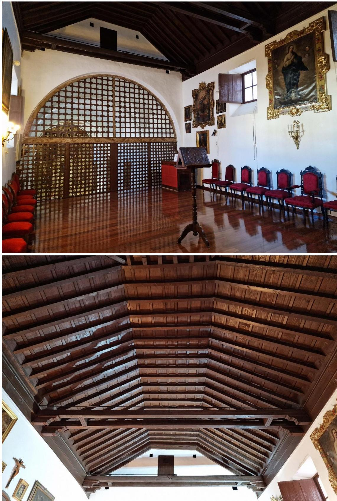
Fotografías 4.14 y 4.15: Coro Alto de la Iglesia de *Las Puras* (Almería). Destacan la celosía frontal y el techo de madera del tipo par y nudillo (con sección en artesa invertida). El artesonado lleva tirantes dobles de madera, sin ornatos ni decoraciones, que se apoyan en canecillos lignarios. Las caras internas del artesonado se acercan al estilo de los techos lignarios de alfarjes. Capturas del 27 de noviembre de 2023.
