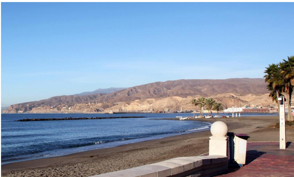
Fotografía 8.38: dique exento (obra marítima paralela a la orilla) para estabilizar el depósito de arena de la Playa de El Zapillo, tras su regeneración sedimentaria artificial. Las corrientes por gradientes de sobreelevación del agua de la mar, provocadas por el dique exento, crean, y/o mantienen, un semi tóbolo (llamado hemitóbolo en Ingeniería Costera), que podría, potencialmente, evolucionar a un tóbolo. Captura del 29 de noviembre de 2022.
