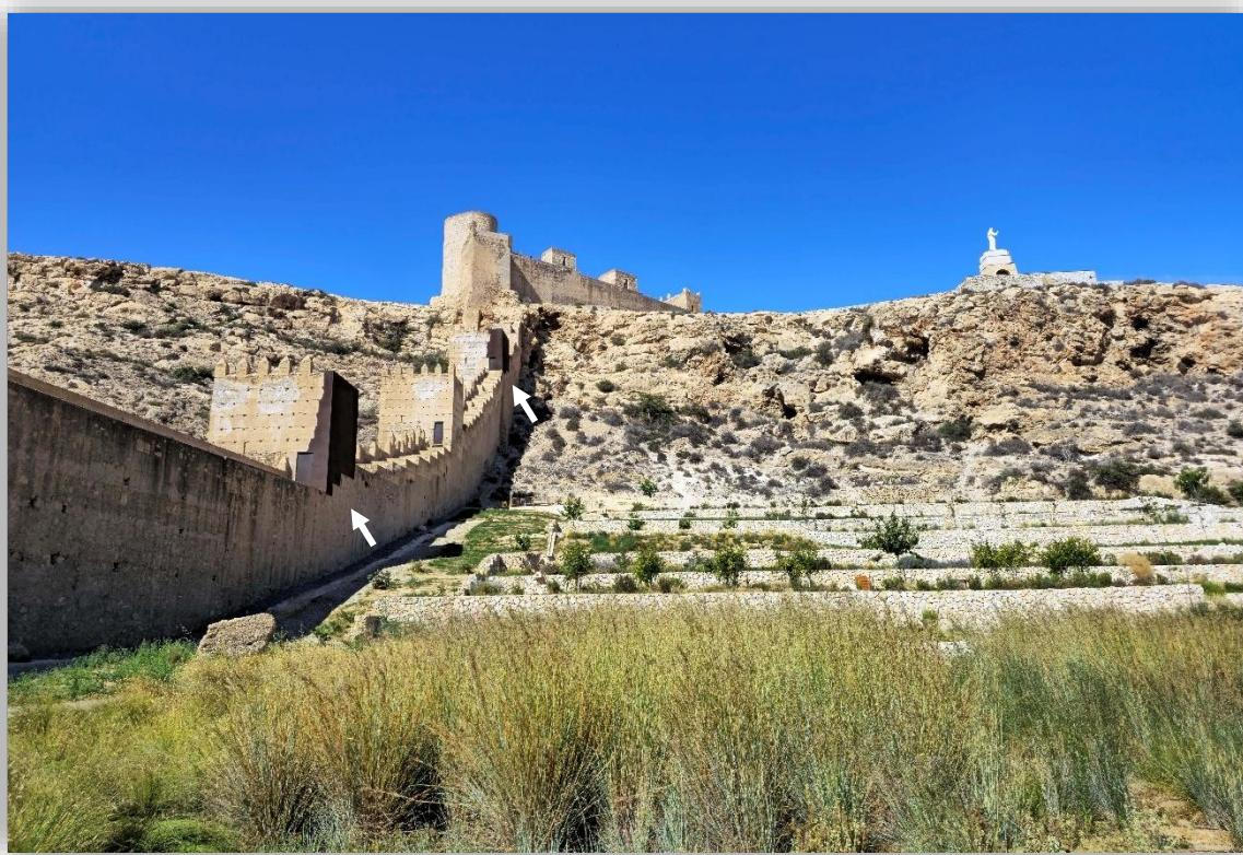
Fotografías 7.37 y 7.38: vista de las murallas de Jayrán, en su tramo que atraviesa La Hoya. Hay dos torreones con planchas de acero corten, colocadas en la restauración del año 2010. Con estas planchas, ¿se quería hacer una aportación artística en las murallas? Sin embargo, según Gil Albaracín (2017), se crearon unas *diatribas* en una de las páginas de la Historia patrimonial almeriense. Capturas del 18 de agosto de 2023 y del 28 de julio de 2025 (de arriba abajo).
