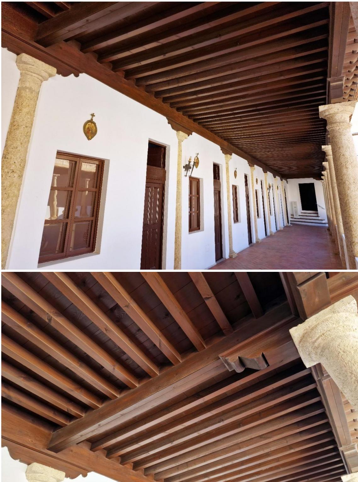
Fotografías 4.20 y 4.21: dos **techos planos lignarios simples**, con **un solo orden de vigas** (las jácenas, que dan apoyo a las tablazones), separados en dos secciones por una **viga maestra**. Los estribos descansan en canecillos dobles apoyados en columnas. Claustro Superior del Convento de *Las Puras* (Almería). Capturas del 27 de noviembre de 2023.
