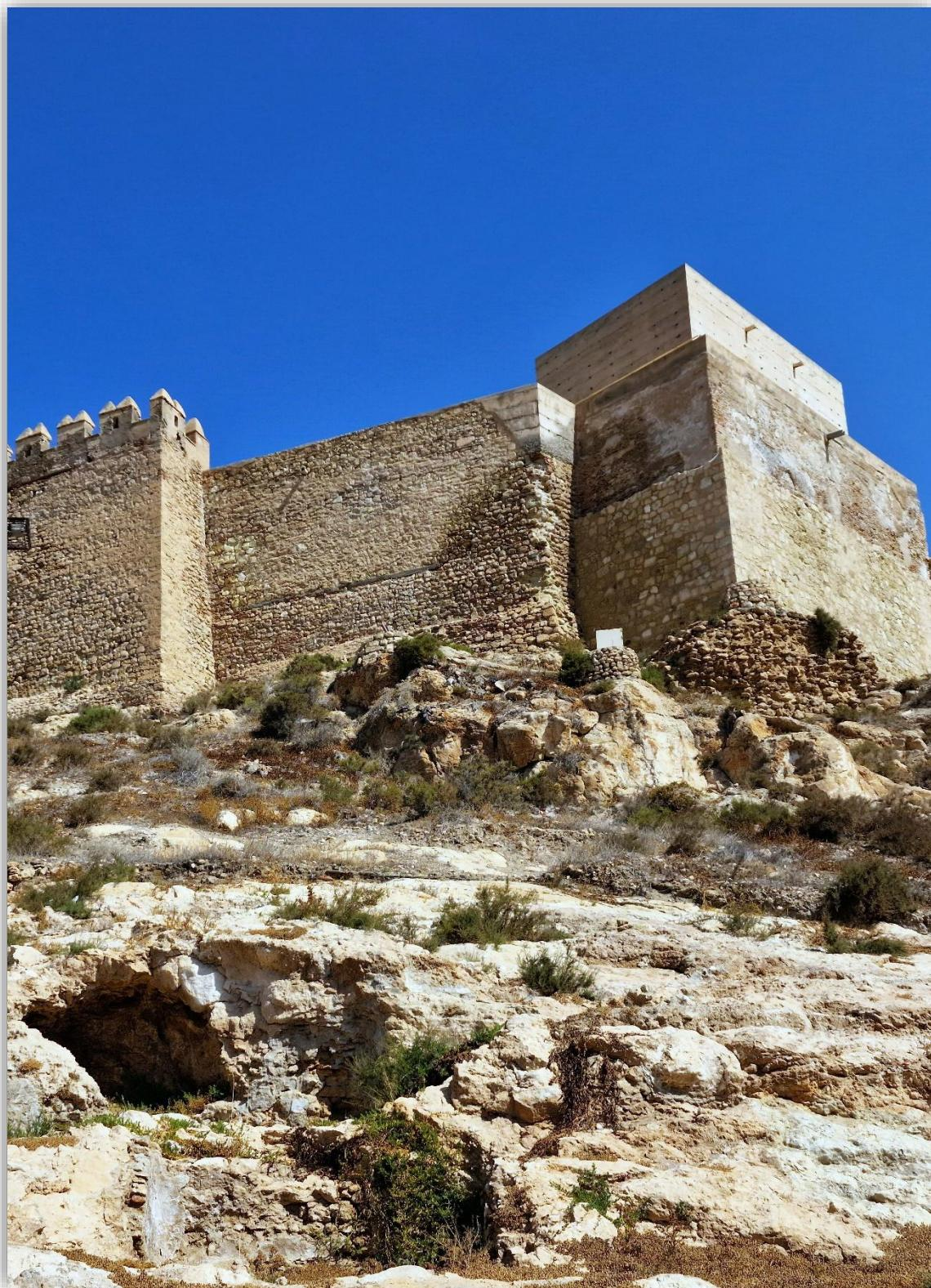
Fotografía 7.30: detalles de la fachada externa suroriental de la Alcazaba. La erosión permite observar que las murallas, de este sector de la fortificación musulmana, fueron construidas en mampostería, con el empleo de piedras y sillares. Captura del 18 de agosto de 2023.
