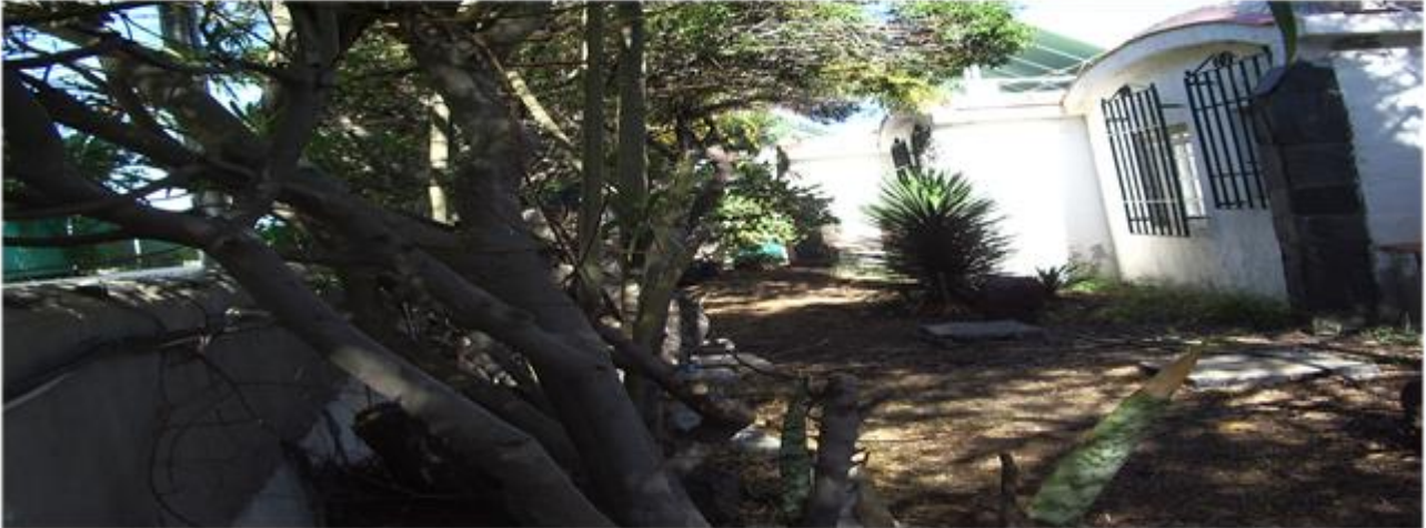
Figura nº 5: Apartamentos en deterioro en la zona de Águila Playa, Gran Canaria (es frecuente observar en áreas residenciales de las zonas turísticas como existe un abandono de la segunda residencia por parte de su propietario, afectando al resto de complejos reglados y, a la competitividad de la zona). Fuente: Elaboración propia.
