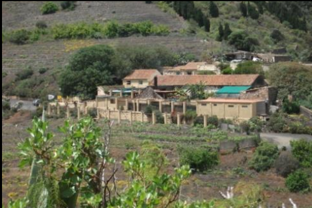
Restaurante Bodegón Vandama
