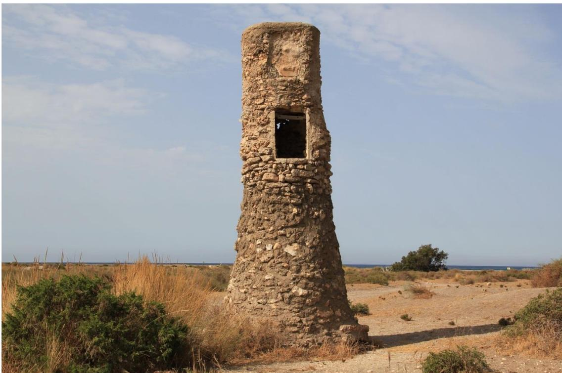
Fotografía 4.7: El Pocico con sus dos puertas más antiguas de explotación del agua en la parte superior de la construcción, cuando el perfil de base del depósito sedimentario estaba más alto respecto al techo del pozo
