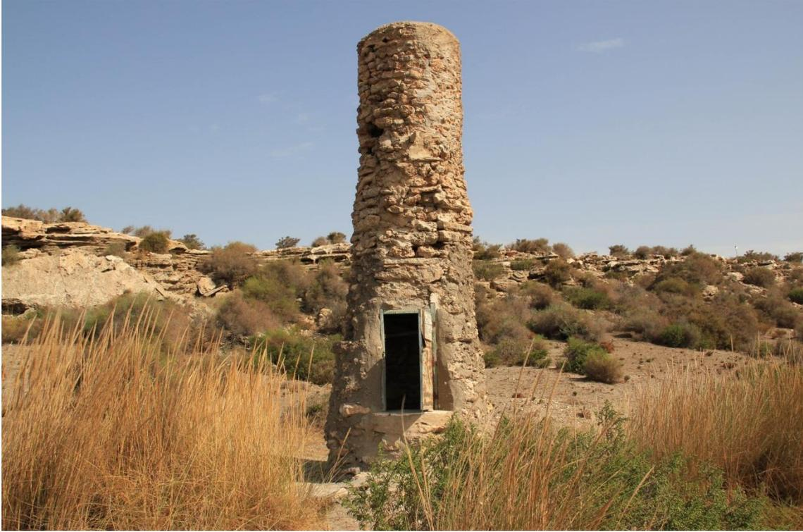
Fotografía 4.8: El Pocico con su puerta de explotación del agua más reciente en la parte inferior de la construcción, al descender el perfil de base del depósito sedimentario en el cauce, en relación con el techo del pozo
