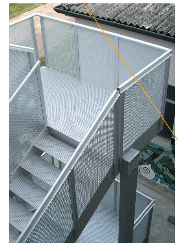
Escalera metálica exterior
