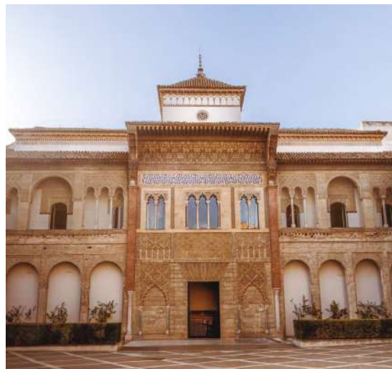
Patio de la Montería del Real Alcázar de Sevilla. Dependencias del Alcázar fueron sede de la Casa de la Contratación. Fotografía de Matyas Sipos-Adobe Stock.
