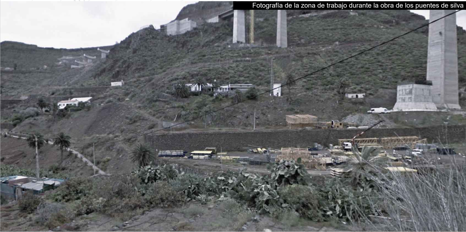
Fotografía de la zona de trabajo durante la obra de los puentes de silva
