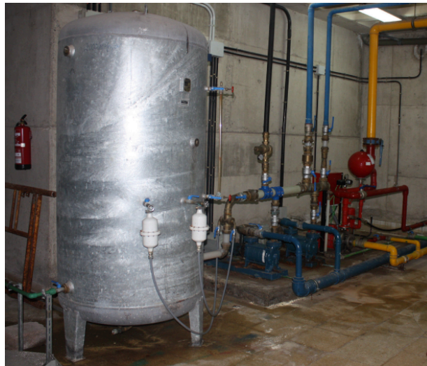
Figura 108: Sala de máquinas Fuente: Elaboración propia
