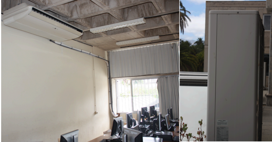
Figura 29: Aire Acondicionado, Sala de Ordenadores C Fuente: Elaboración propia
