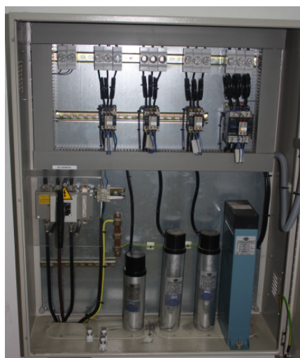
Figura 6: Batería de condensadores. Fuente: Elaboración propia
