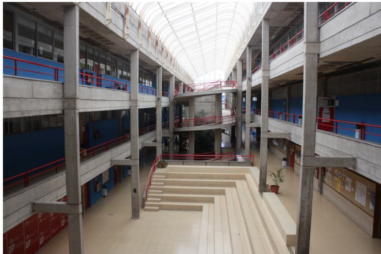
Figura 2: Patio interior con imagen del lucernario. Fuente: Elaboración propia
