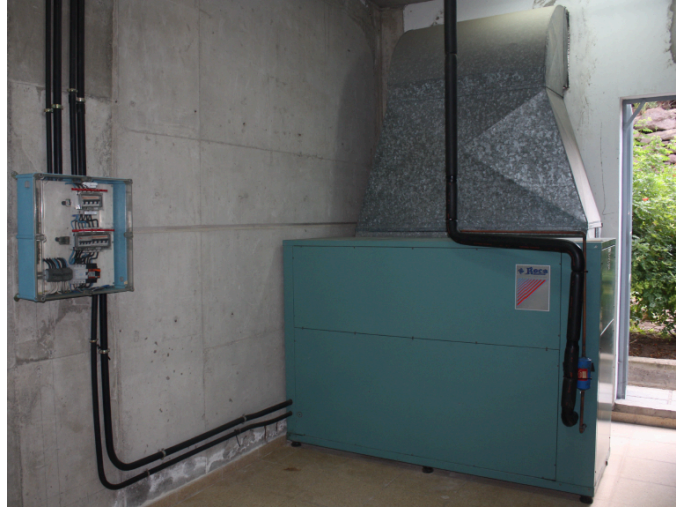
Figura 107: Unidad Exterior Aire Acondicionado, Salón de Actos Fuente: Elaboración propia
