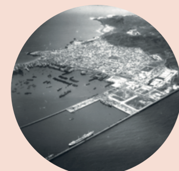
Terminación segundo dique y escollera en 1935.
