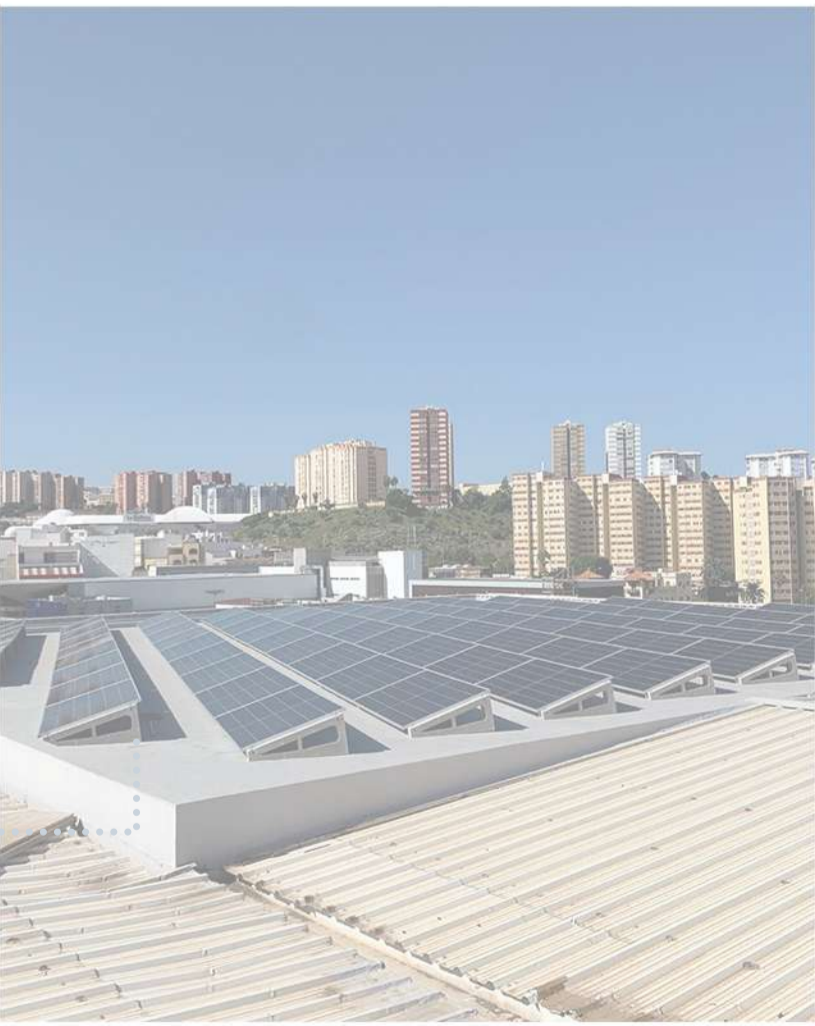
Colocación de paneles orientados al sur para su máximo rendimiento.
