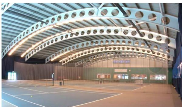
Figura 1. Vigas celulares em um ginásio poliesportivo, [1]
