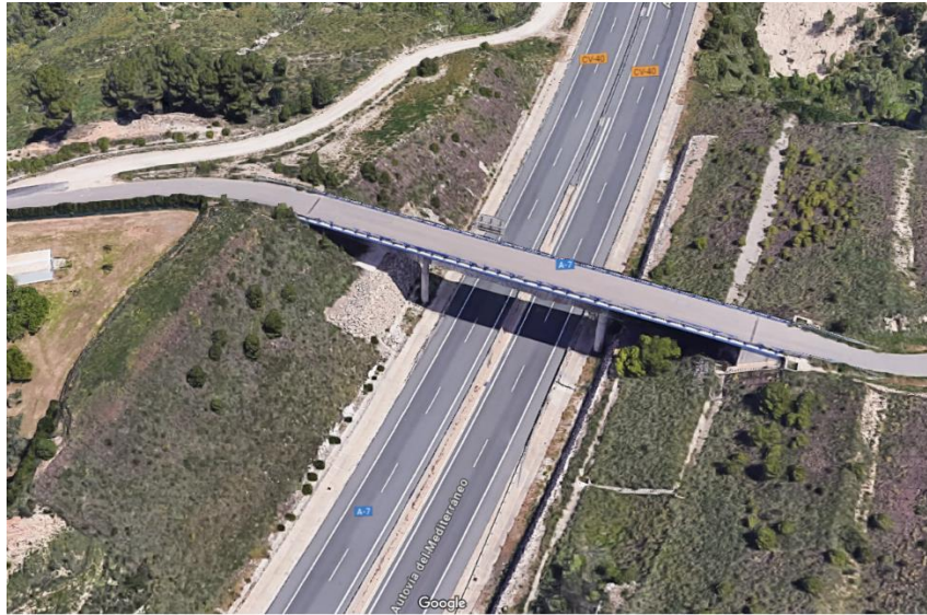
Figura 3. Imagen aérea del paso superior en el kilómetro 441 de la autovía A-7, en el término municipal de Cocentaina (Alicante). Imagen: Google Maps.
