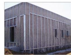
01. SUBESTRUCTURA DE ACERO SOBRE CAPA INTERIOR DEL CERRAMIENTO
