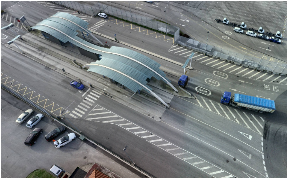
Figura 1.1: Terminal de acceso Raos del Puerto de Santander 1 .
