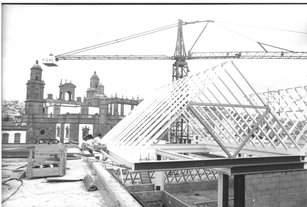
Figura 1. Construcción de la cubierta acristalada del CAAM, 1988
