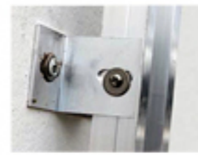
Atornillado de perfiles omega a los separadores o dobles 'T'.
