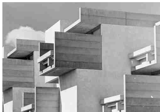
Agrupación Frontera (1970-1974), las terrazas en obra.
