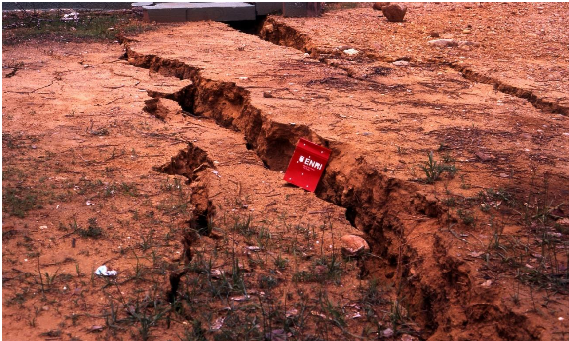
Fotografía 8.105: observación de fracturas, por movimientos sísmicos, en la ribera norte del Golfo de Cariaco, entre las ciudades de Cumaná y Cariaco (Venezuela). Estas fracturas se formaron en las proximidades inmediatas de unos miradores de paisaje sensorial. El cuaderno de notas, que se utiliza como escala de las aberturas de las fracturas, pertenece a uno de los autores. En general, aparecieron numerosas fracturas en todo el ámbito de afectación del sismo. Captura del 10 de julio de 1997.
