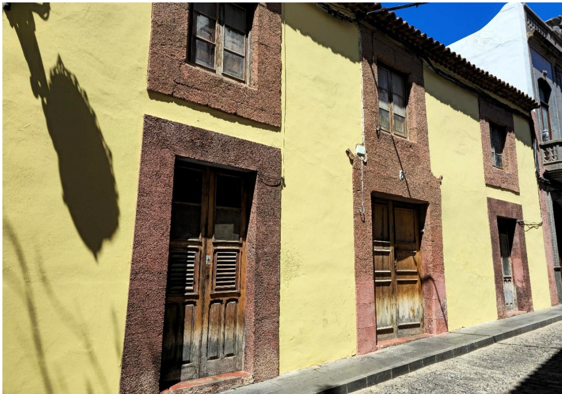
Fotografías 11.19 y 11.20: fachadas de casas que dan a la acera más septentrional de la Calle San José (Guía de Gran Canaria). De arriba abajo, se encuentra la casa natalicia de don Néstor Álamo, y la casa de los pajaritos (por el esculpido de dos pájaros en los extremos inferiores del cuerpo de cantería, a modo de ménsula, que soporta el vano de una ventana central, y que se apoya en el dintel de la puerta). Ambas casas, por sus ubicaciones en el callejero y por sus reminiscencias en las tipologías edificatorias internas y externas, eran, en sus orígenes, renacentistas. Capturas del 4 de mayo de 2024.
