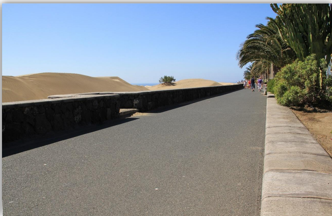
Fotografías 3.25 y 3.26: mirador dinámico del Paseo Sahara Beach Club (Isla de Gran Canaria), en un marco urbano vacacional-turístico. El paseo, que conforma el mirador dinámico, franquea a una parte importante del Campo de Dunas de Maspalomas. A lo largo de su recorrido, se obtienen panorámicas muy ricas en diversidad geométrica, protagonizadas por los depósitos sedimentarios eólicos de arenas, en movimiento. Capturas del 20 de marzo de 2011.
