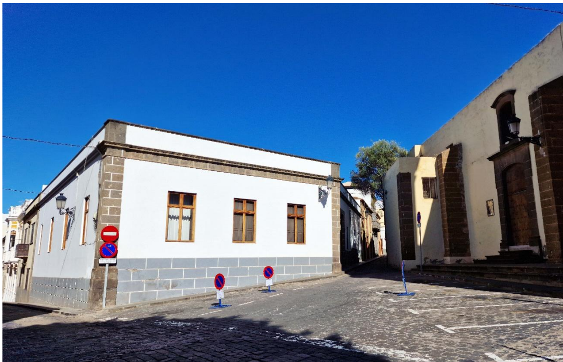
Fotografías 11.21 y 11.22: de arriba abajo, fachada principal y lateral de la casa nº 1 de la Calle San José, ocupada, en la actualidad, por doña Reyes Guerra. Capturas 15 de abril (imagen superior) y del 27 de marzo (imagen inferior) de 2024.
