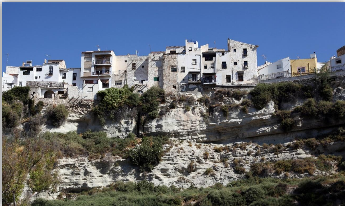
Fotografías 3.33 y 3.34: Casas Colgantes del Pueblo de Sorbas (Almería), desde su mirador dinámico, acondicionado en el borde septentrional de la carretera N-340a. Capturas del 14 de agosto de 2013.
