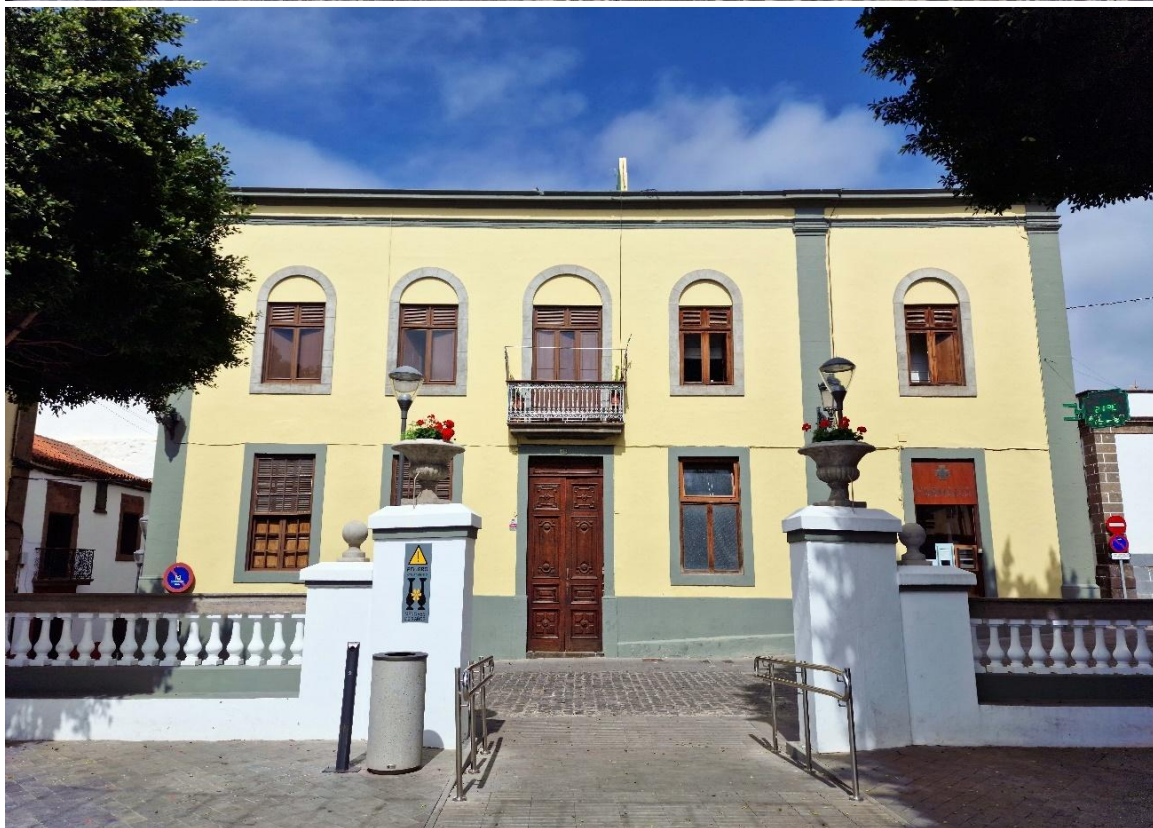
Fotografías 11.23 y 11.24: Casona de la Plaza Grande n° 1, de siglo XIX. La tipología edificatoria externa es neoclásica, con algunos añadidos posteriores (los arcos rebajados de la segunda altura fueron incorporados en unas reformas realizadas en la década de los años 50, del siglo XX). Capturas, de arriba abajo, del 27 y del 25 de marzo de 2024.
