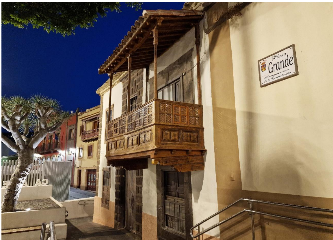
Fotografías 11.5 y 11.6: vistas frontal y lateral de la Casa de Los Quintana, originaria del siglo XVI. Capturas del 14 de noviembre de 2023.
