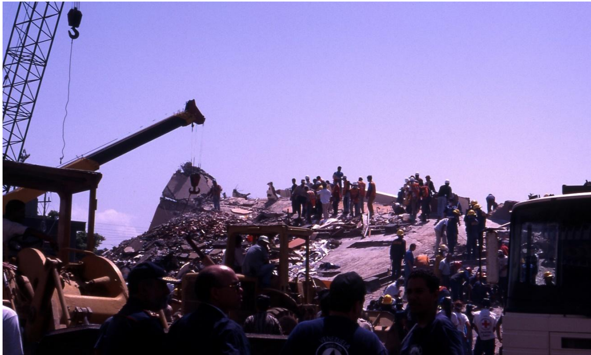
Fotografía 8.108: escombros de la torre Edificio La Seguridad, tras su derrumbe por el sismo del 9 de julio de 1997, en la Ciudad de Cumaná (Venezuela). Captura del 10 de julio de 1997.
