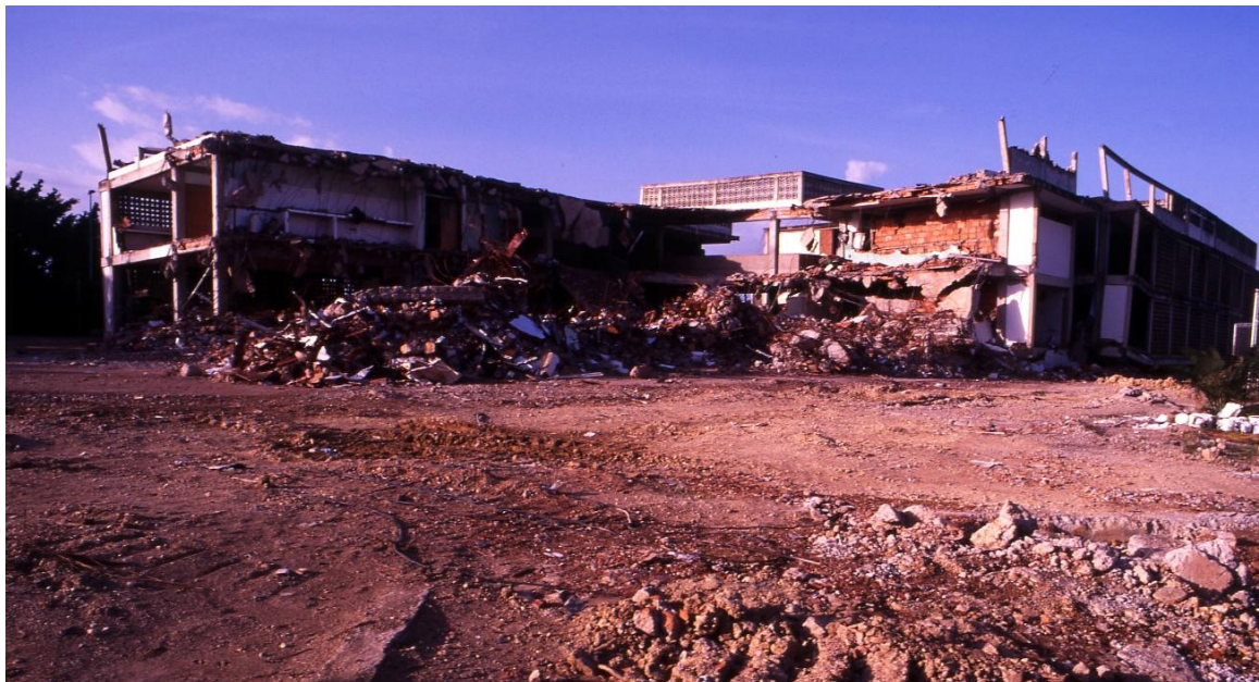
Fotografía 8.109: escombros del Liceo Raimundo Centeno, tras el derrumbe del centro escolar por el sismo del 9 de julio de 1997, en la Ciudad de Cariaco (Venezuela). Captura del 10 de julio de 1997.
