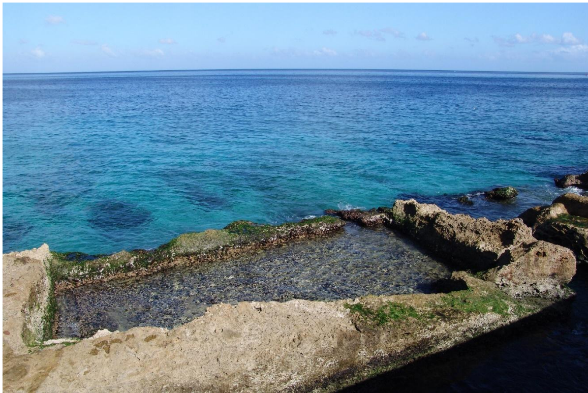
Fotografías 1.7 y 1.8: pocetas y zanjas labradas en la rasa rocosa, con una superficie ruinosa por la erosión marina (en dientes de perro ), al pie del Malecón de La Habana. Se excavaron para la evacuación de las aguas negras de muchas casas de la calle San Lázaro. Antes de la construcción de El Malecón. La fila noroeste de casas de la Calle San Lázaro, entre las calles Padre Varela y Galiano, formaba el frente trasero de la prolongación de la Ciudad, hacia la desembocadura del Río Almendares. Con el paso del tiempo, las pocetas se reutilizaron como peligrosas piscinas abiertas a la mar, para el baño de muchos. Dentro de un paisaje sensorial urbano, representan contenidos estructurales . Los puntos de observación de estos contenidos se encuentran sobre el muro de El Malecón. Capturas del 3/1/2007.
