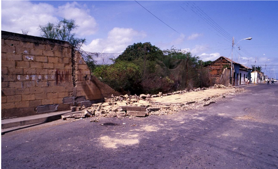
Fotografía 8.104: derrumbes de tapias, en la Ciudad de Cumaná (Venezuela), tras el paso del sismo del 9 de julio de 1997. Captura del 10 de julio de 1997.
