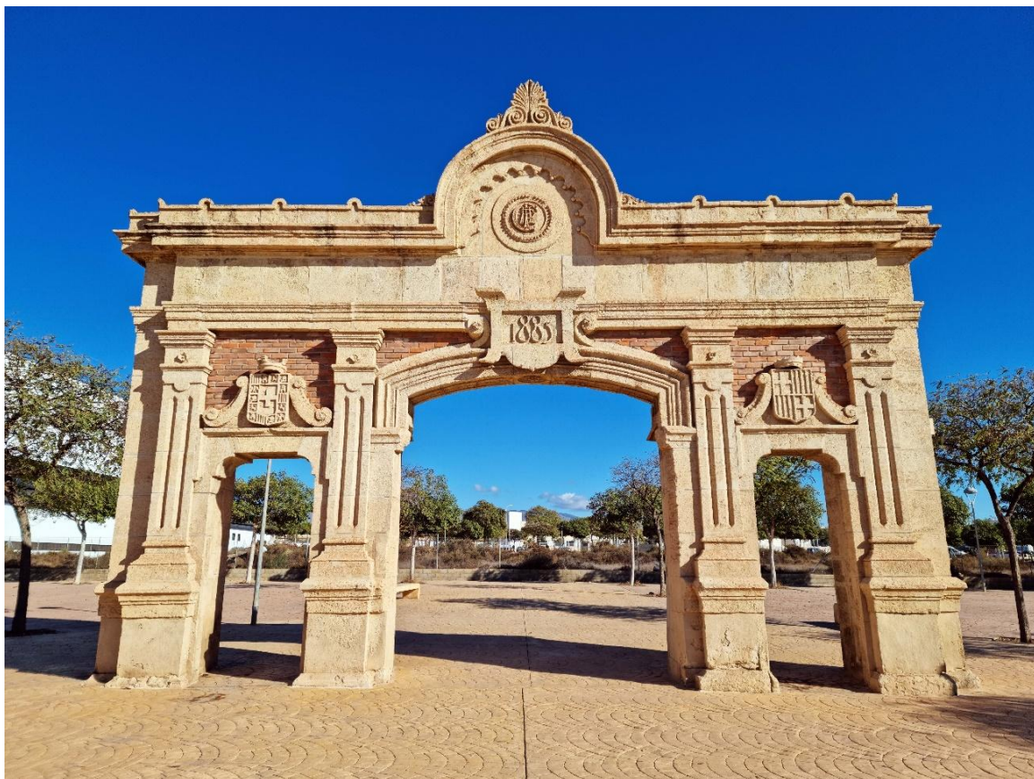
Fotografía 1.1: Puerta del Ingenio, proyectada y construida por don Enrique López Rull, en el año 1885. Para algunos, esta puerta podría despertar recuerdos heredados en una cuenca paisajística sensorial urbana, en la periferia de la Ciudad de Almería (entre Los Molinos y El Puche). Captura del 3 de diciembre de 2022.
