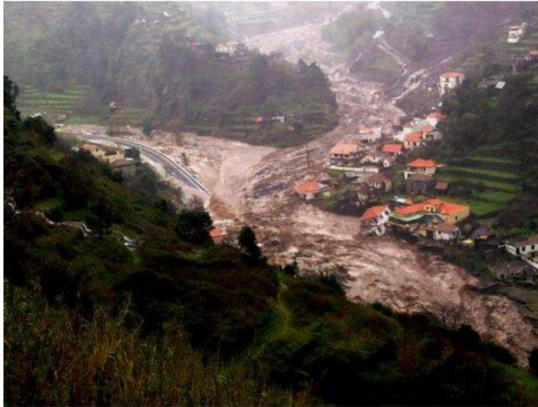
Figura 7.6.1.1 | Foto que muestran los efectos destructivos de las inundaciones repentinas y los deslizamientos de tierra del 20 de febrero de 2010 en la isla de Madeira. Fuente: Fragoso et al (2012).
