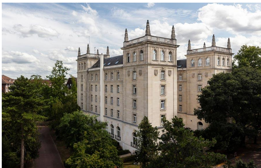
FIGURA 1. Colegio de España en su estado actual
