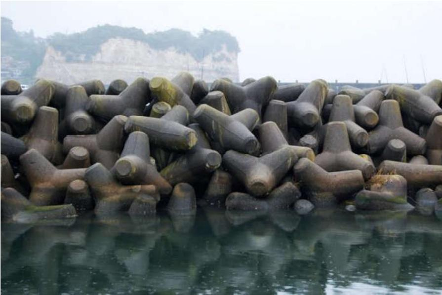
Fig. 2. Barrera de tetrapodos. Fotografía: Gianpaolo Fusari
