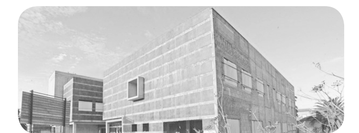
CENTRO DE SALUD EL CRISTO. LA LAGUNA. ABANDONO EN 2011 Paralizado por incumplimiento de contrato, lleva varios años abandonado, nadie se hace responsable de la obra.
