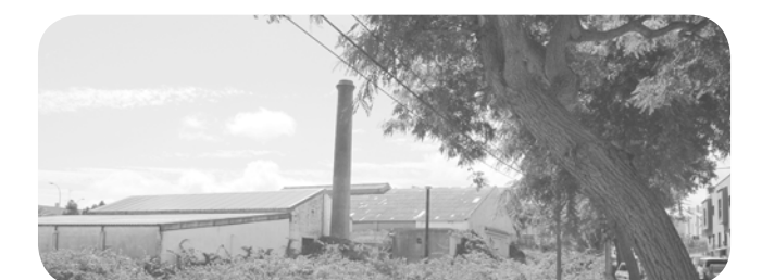
FÁBRICA ANCHIETA. LA LAGUNA. ABANDONO EN 2007 Quiebre de la empresa propietaria, dedicada a la fabricación de materiales de construcción.
