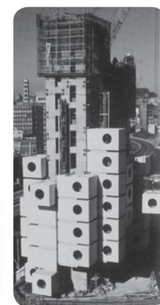
La **NAGAKIN TOWER**, se compone de dos torres con un núcleo de hormigón al que se conectan 140 cápsulas, todas ellas prefabricadas y diseñadas para ser desmontables y reemplazables. Cada una de las cápsulas, de 8.8 m<sup>2</sup>, resuelve los servicios básicos y necesidades de cada individuo. Las cápsulas son ligeras cajas de acero revestidas con paneles de acero galvanizado, y están conectadas independientemente al núcleo de hormigón.
