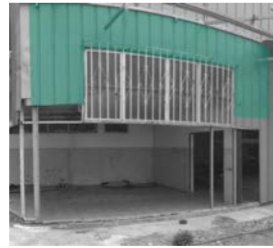
_Chapacerramiento fábrica _Ventana mirador
