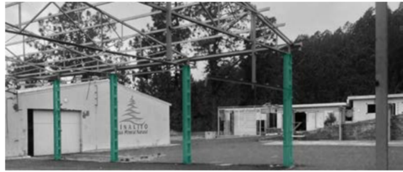
_4 perfiles dobles de acero laminado (0.35x0.20x3.50m) _Escultura "ESFUERZO" (6m altura)
