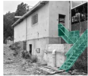
_Escalera metálica _Escalera metálica
