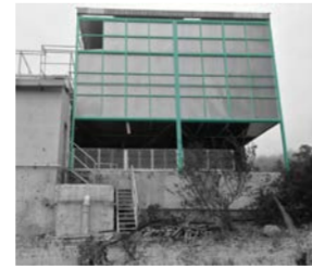
_Montantes y travesaños _Celosía metálica
