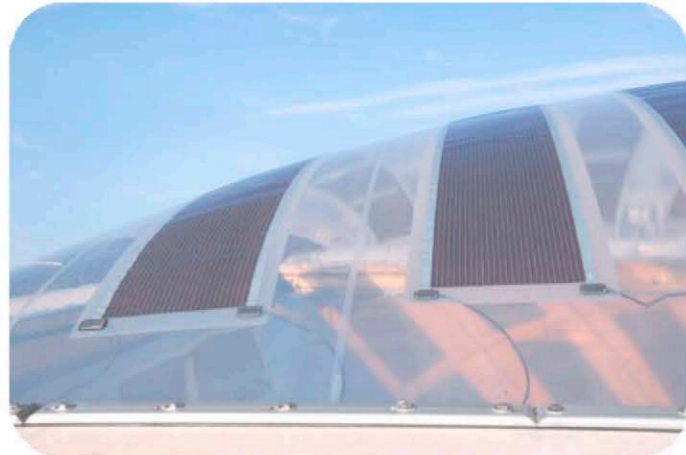
Sistema de captación Solar integrados en los cojines de láminas ETFE
