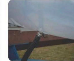
Distribución del aire de inflado para los cojines ETFE
