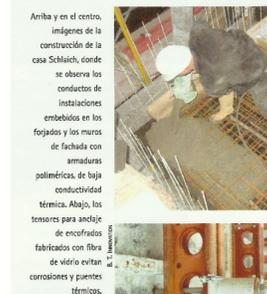
Arriba y en el centro, imágenes de la construcción de la casa Schlaich, donde se observa los conductos de instalaciones embudidos en los forjados y los muros de fachada con armaduras poliméricas de baja conductividad térmica. Abajo, los tensores para anclaje de encofrados fabricados con fibra de vidrio evitan corrosiones y puentes térmicos.
