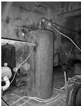
Depósito de un pozo para acumulación de aire comprimido (La Lechucilla).
