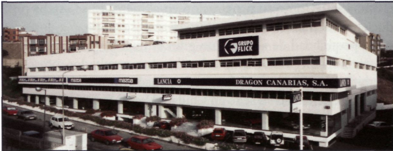
Instalaciones de Dragón Canarias en la zona industrial de Miller Bajo (1989).
