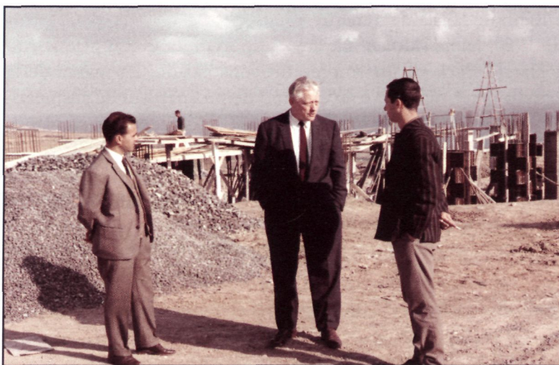
En las obras de las instalaciones de Escaleritas, Santiago Cabrera y Luis Díaz flanquean a Harald Flick.
