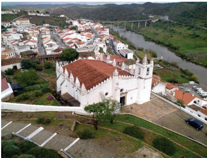
Figura 30. Igreja Matriz de Mértola (Fot. P. Méndez).
