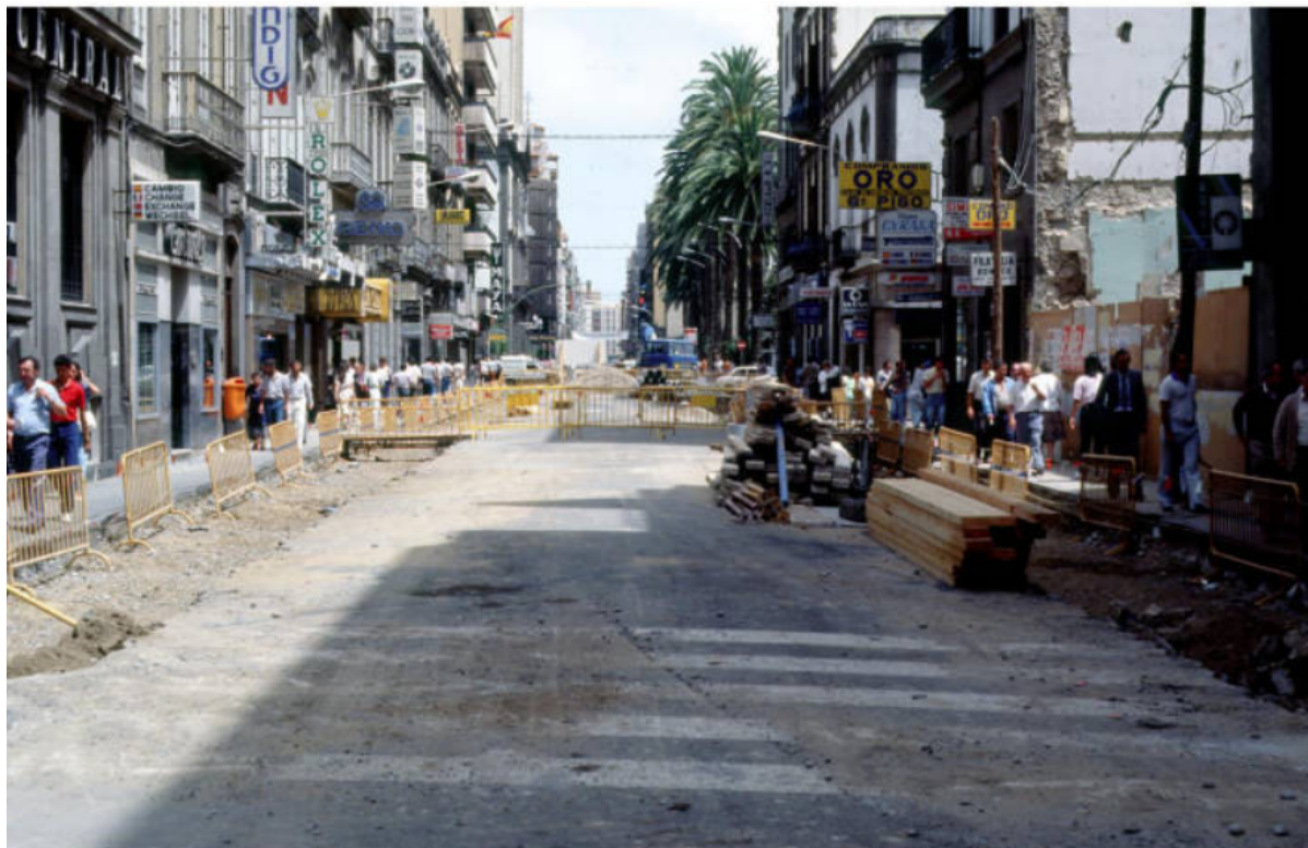
Calle Mayor de Triana en obras. Año 1985.
