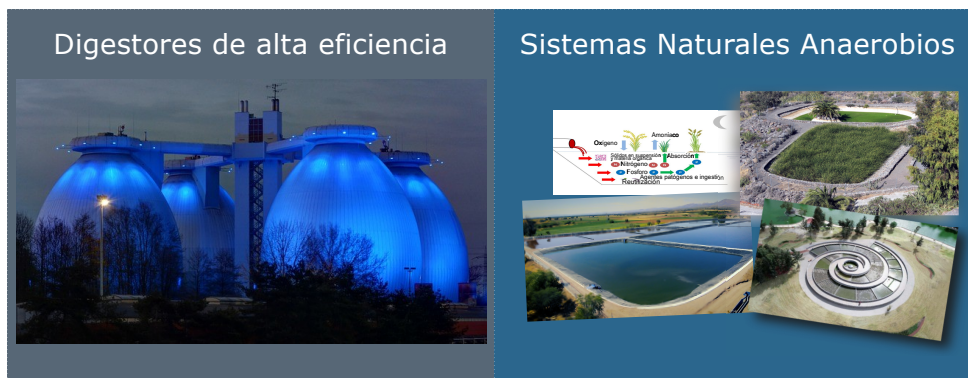
Figura 3: Izda. Planta de biogás compuesta por digestores anaerobios termófilos a mezcla completa. Dcha. Sistemas de depuración natural formada por humedales, lagunas anaerobias y estanques de maduración
