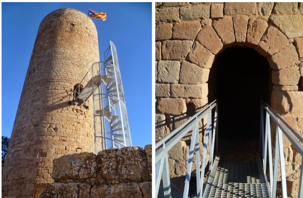
Fig. 8. Torre de la Manresana (Els Prats de Rei, Barcelona) restaurada por el arquitecto Antoni González Moreno-Navarro. Fotos de M a Carmen Diez Carrera
