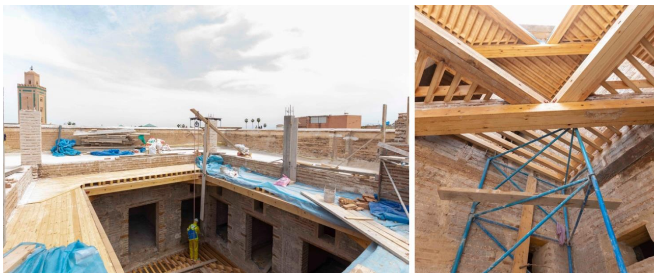
Fig. 61. Estado de las obras en abril de 2020. Fotos del autor
