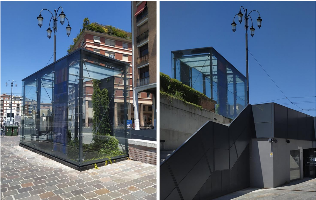
Fig. 110. Volumen transparente que sirve de tótem identificativo y de pozo de luz para los ámbitos subterráneos. Fotos del autor
