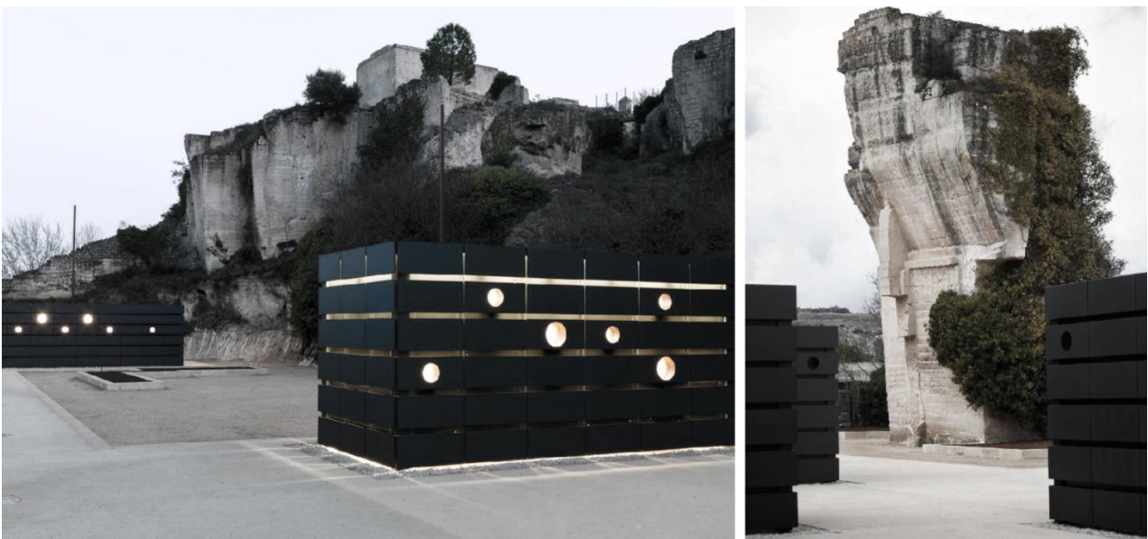
Fig. 96. Pabellones de madera que configuran el área comercial y de servicio. Imágenes cedidas por el arquitecto Mattia Antonio Acito.
