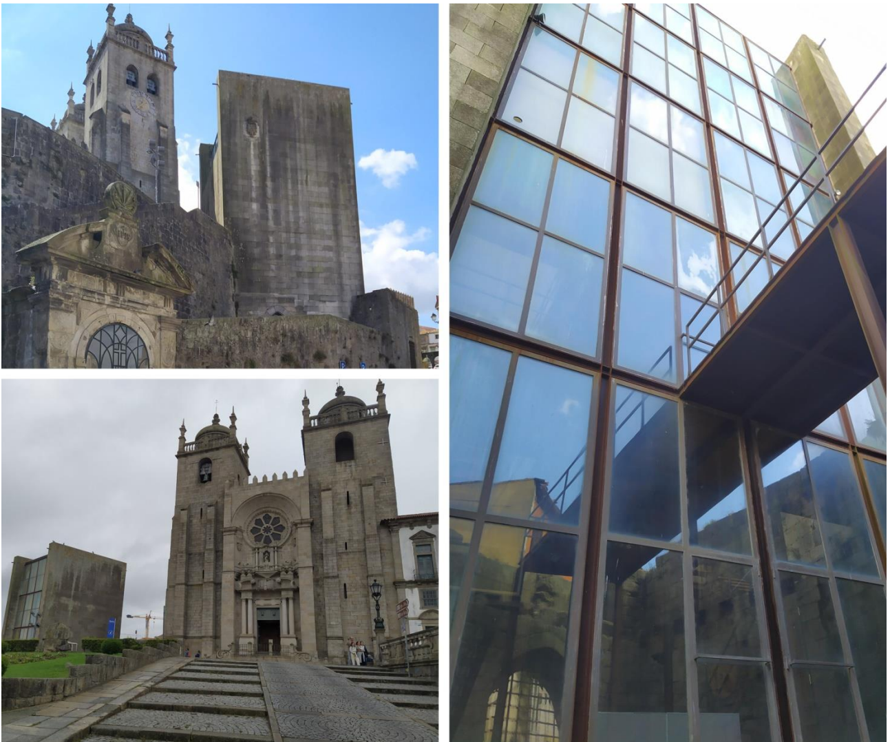
Fig. 84. Estado de la Casa dos 24 en noviembre de 2020. Fotos del autor
