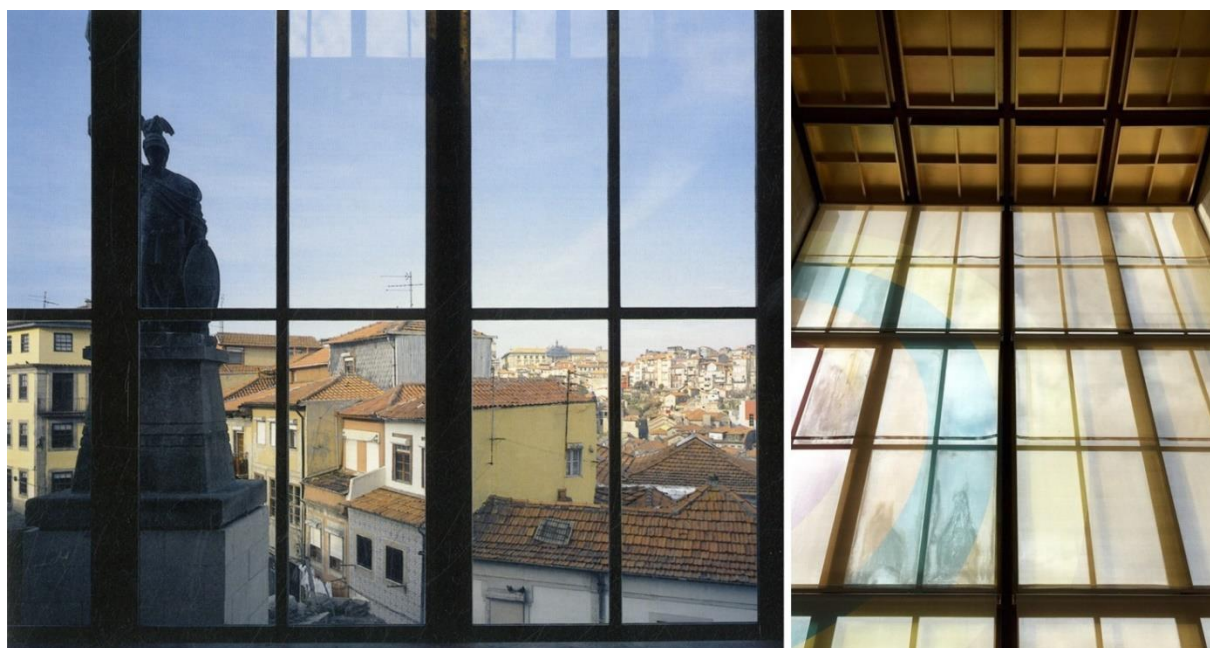
Fig. 82. Ventanal trastero y techo de la Casa dos 24
