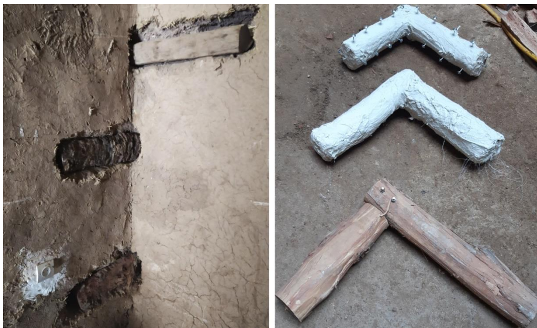
Fig. 56. Encuentro de dos paredes en tierra cruda, diferencias entre los métodos empleados en Tamnougalt y en la Foundouk Moulay Boubker . Fotos del autor
