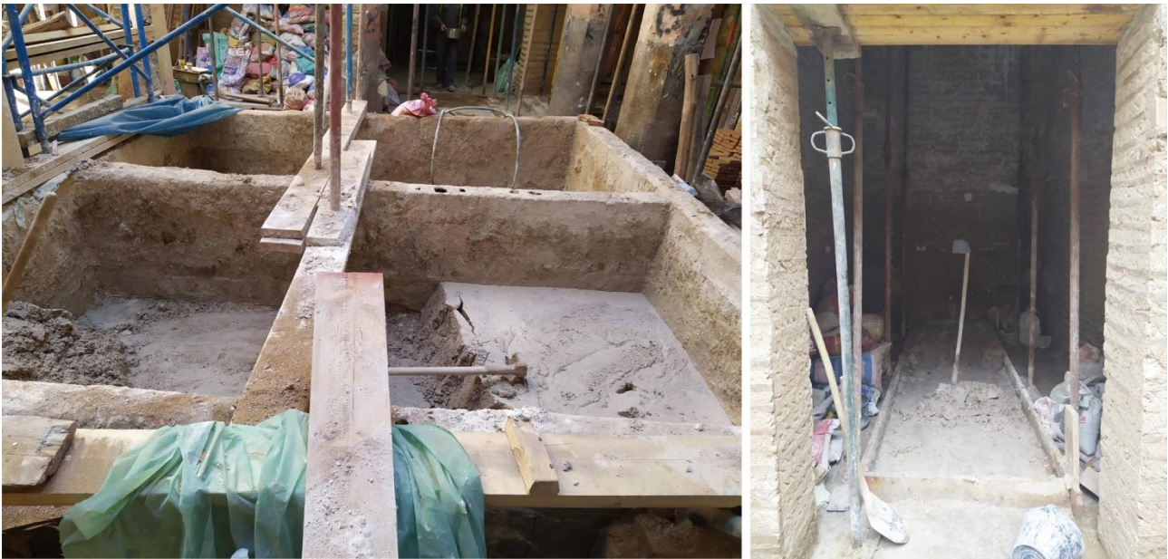
Fig. 63. Preparación de la chaux . Fotos del autor
