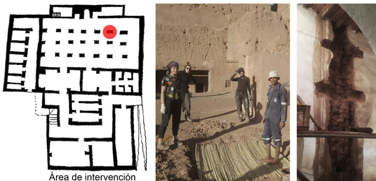
Fig. 40. Levantamiento y reparación de la madrasa de Tamnougalt mediante el añadido de un entramado formado por cañas de bambú que sirvió para sujetar la capa de mortero y tapar de forma definitiva las filtraciones de agua. Elaboración propia y foto del autor
