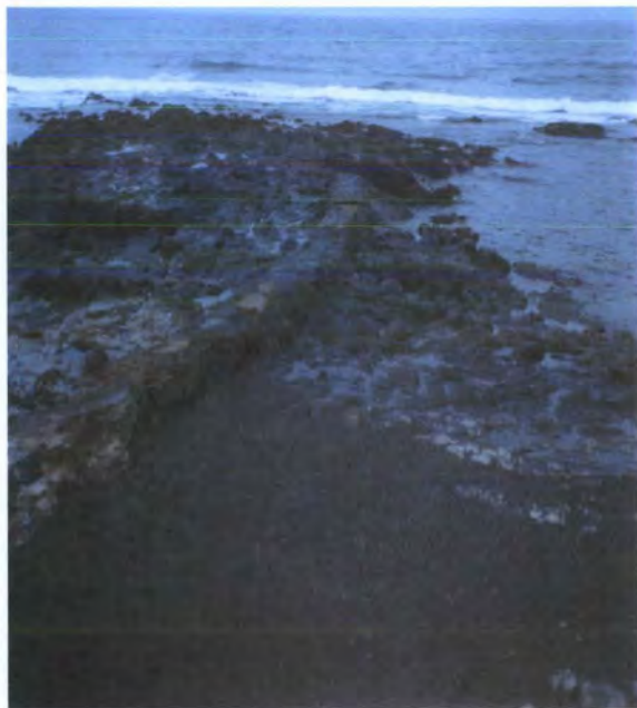
Foto: conducción de desagüe en San Cristóbal (Las Palmas de Gran Canaria)
