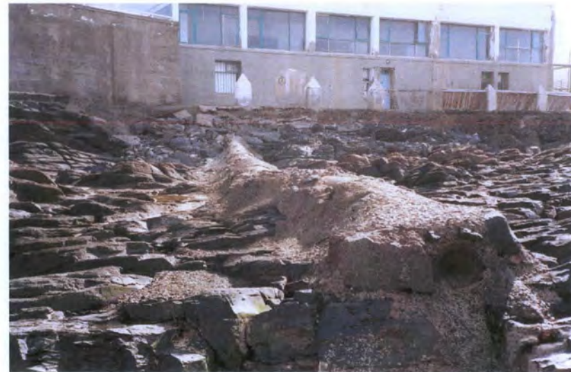
Foto: conducción de desagüe en Quintanilla (Arucas)
