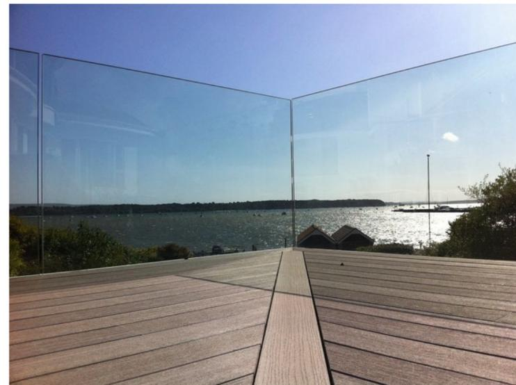
BARANDILLA TERRAZA - MIRADOR, DE CRISTAL LAMINADO DE SEGURIDAD CON SISTEMA DE ANCLAJE RETRANQUEADO.
