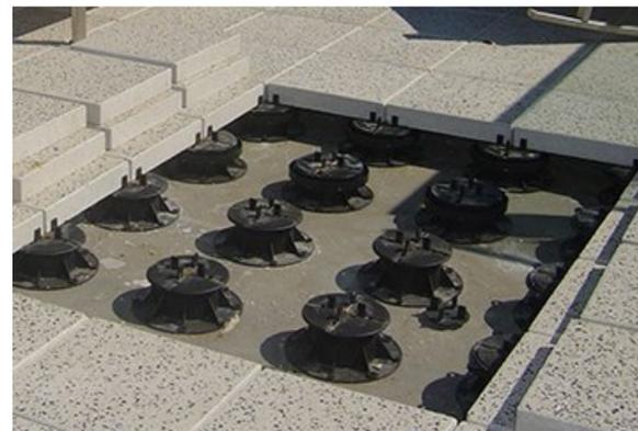
SISTEMA DE PLOTS REGULABLES EN ALTURA DE PVC PARA COLOCACIÓN EN EXTERIOR EN TERRAZA - MIRADOR
