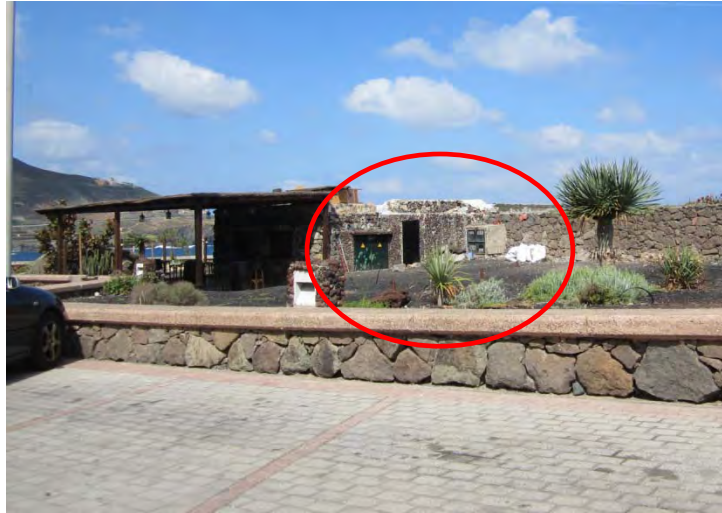
Figura 54: Estado actual de la puerta de acceso a la cocina del restaurante Mirador del Atlante y que quedaría tapada con la cartelería del área experimental.
