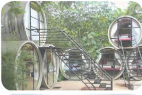
**TUBOHOTEL EN MÉJICO, T3ARC**\_ Se construye a partir de tubos de hormigón reciclado. Cada habitación es un tubo y se apilan de tres en tres.
