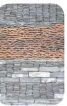
**MUSEO HISTÓRICO DE NINGBO, WANG SHU**\_ Ladrillos tradicionales, tejas y azulejos reciclados. Paredes recubiertas de cemento mezclado con bambú.
