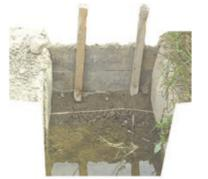
**2. NUDO DE REPARTO\_** articulación donde se encuentran distintas vías de riego, modificando el recorrido según se requiera con la utilización de "tablachos"
