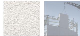
Detalle de muro de HA con acabado abujardado. En otros puntos del proyecto el acabado es el mismo pero se emplean paneles prefabricados de hormigón arquitectónico, como por ejemplo los que ejecuta la casa ESCOFET.
