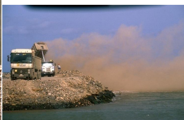
Figura 13. Vertido de material 'todo uno' de cantera durante las obras de construcción del Puerto Industrial de Arinaga, SE de Gran Canaria. Fotos: Vicente Benítez.
