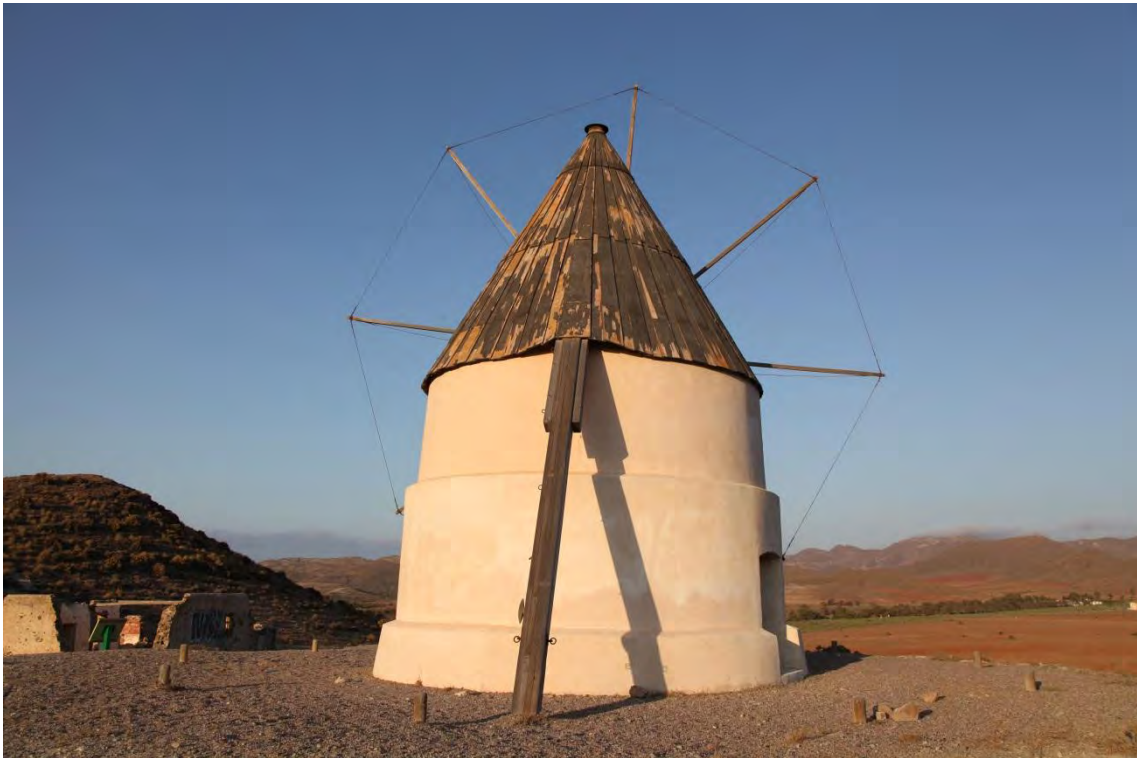
Fotografía 1.82: timón del molino del Collado de Los Genoveses (Parque Natural del Cabo de Gata-Níjar, Almería)
