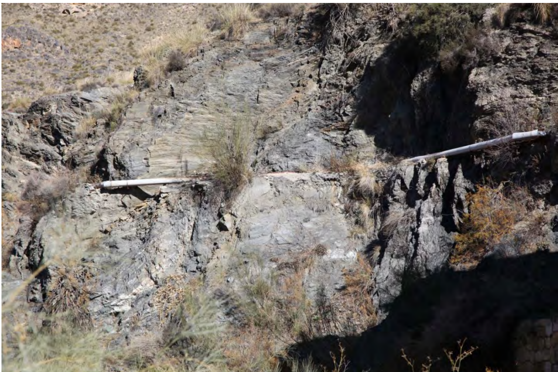
Fotografía 1.65: detalle del reemplazamiento de un tramo de acequia por tuberías en el entorno del Puente La Rafaela
