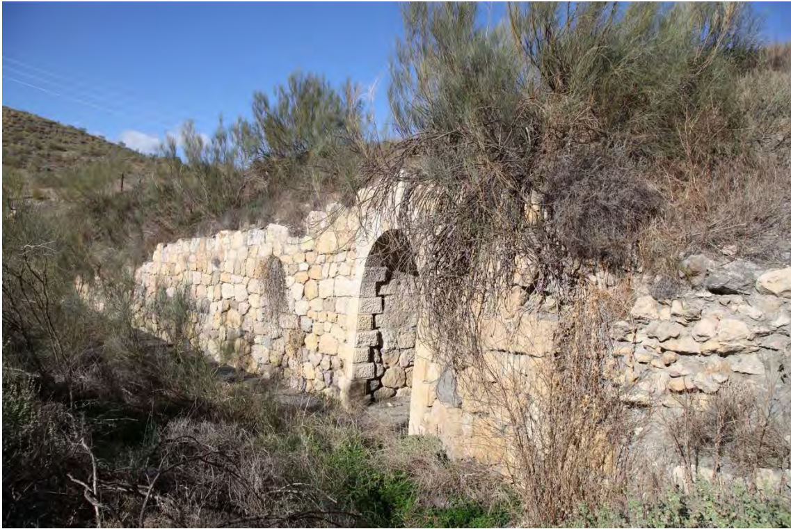
Fotografía 1.8: Puente de El Caballo. Sobre esta infraestructura del trazado ferroviario pasa actualmente la carretera de Polopos
