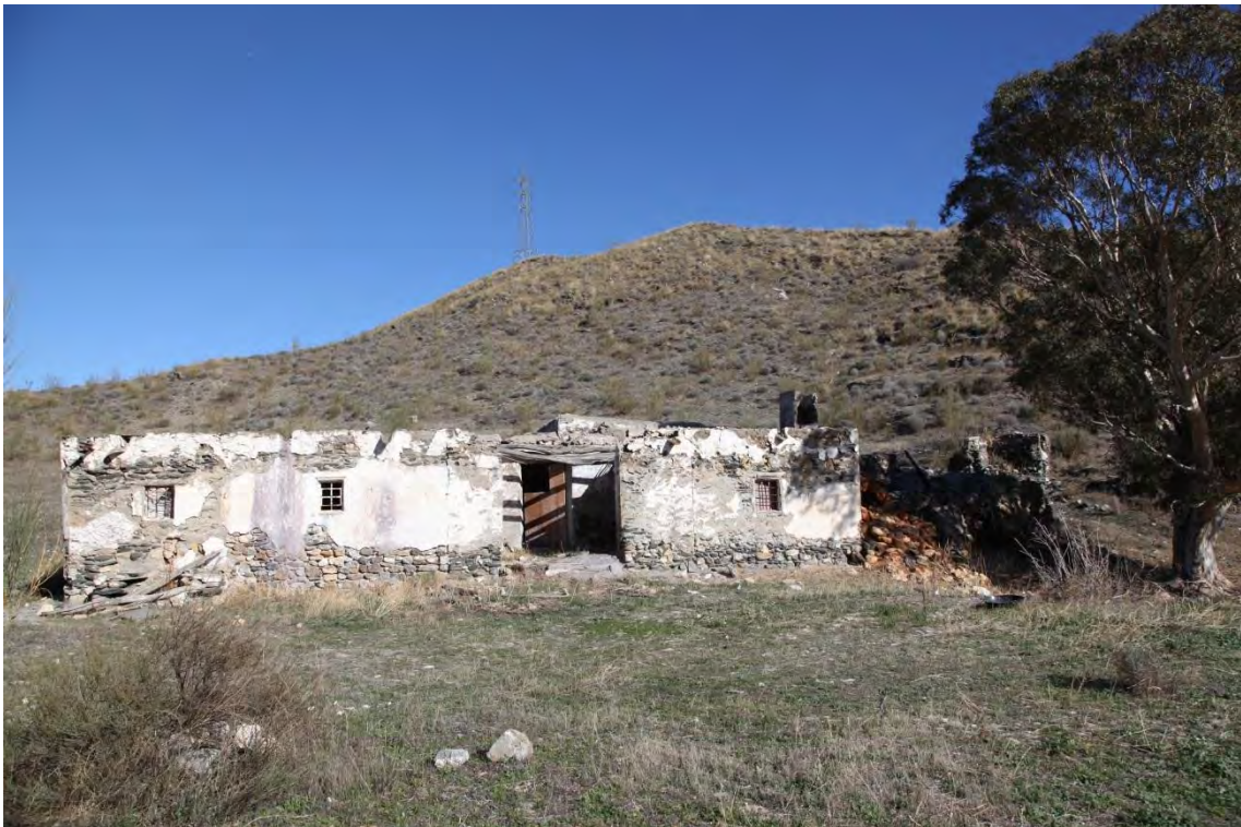
Fotografía 1.21: primer plano de la fachada principal del Cortijo Las Peñicas. Se trata de un cortijo con terrao , en la zona de El Saltador
