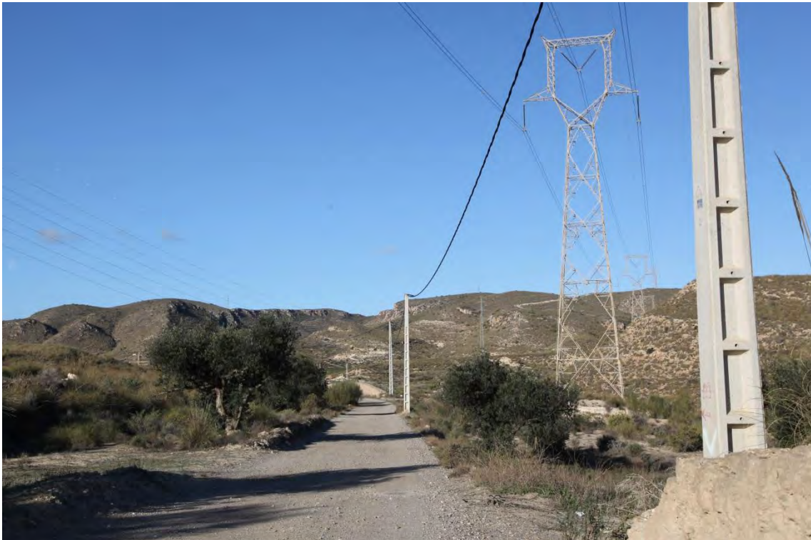
Fotografía 1.45: camino terrero prácticamente sobre el trazado del ferrocarril minero entre Lucainena de las Torres y Agua Amarga, flanqueado actualmente por tendidos eléctricos sub-aéreos y otros, y cruzado por tendidos de alta tensión, entre el segundo paso elevado y el Puente de Polopillos
