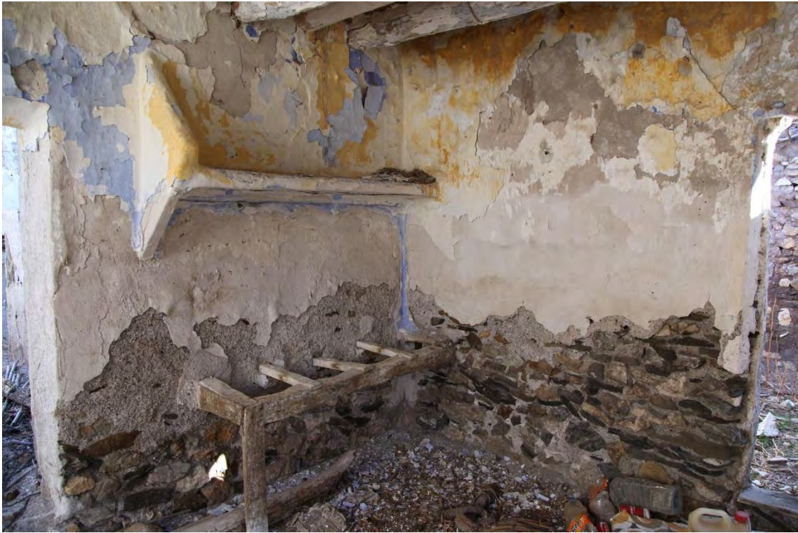
Fotografía 1.28: repisa de cañas y yeso, y cantarera de madera fijada a la pared, en la cocina del Cortijo Las Peñas
