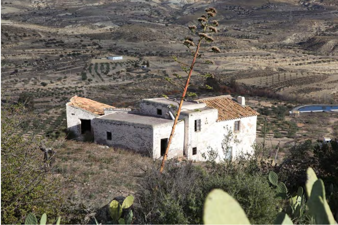
Fotografía 1.30: Cortijo de don “Francisco Góngora”, de tipología edificatoria híbrida (con tejados de teja árabe roja de arcilla cocida y con terraos , en el mismo cuerpo habitacional), en la zona de El Marchal
