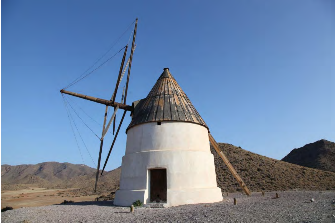
Fotografía 1.81: deterioro de la pintura protectora del chapitel del molino del Collado de Los Genoveses (Parque Natural del Cabo de Gata-Níjar, Almería), tomada en agosto de 2014
