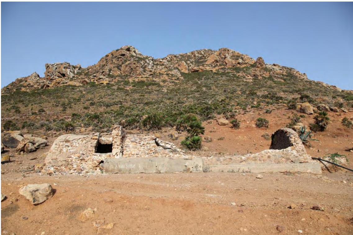
Fotografía 5.6.6: vista frontal del aljibe en bóveda de cañón, del Sendero de Requena, con el decantador a la derecha, la ventana de extracción a la izquierda, y los abrevaderos y piletas para el lavado en la zona central
