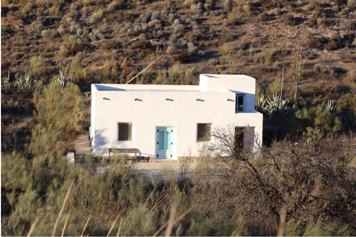
Fotografía 1.48: cortijo adicional de doña Claudia Scholler, con mantenimiento, en la zona de El Saltador. Su tipología edificatoria es de terrao
