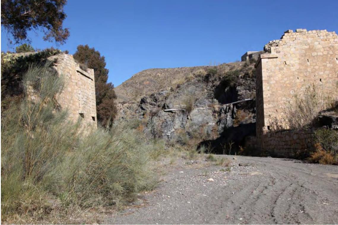
Fotografía 1.64: reemplazamiento de un tramo de acequia por tuberías en un sector de filitas que crea inestabilidad geomorfológica de ladera, en el entorno del Puente La Rafaela
