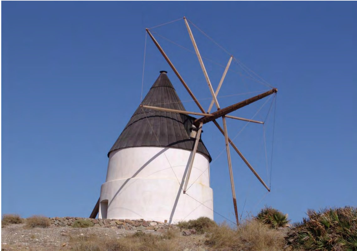
Fotografía 1.79: fachada oeste del molino de viento de chapitel móvil, con cuerpo tronco-cónico escalonado, en el Cerro del Avemaría , límite con el Campillo de Los Genoveses (Parque Natural de Cabo de Gata-Níjar, Almería)
