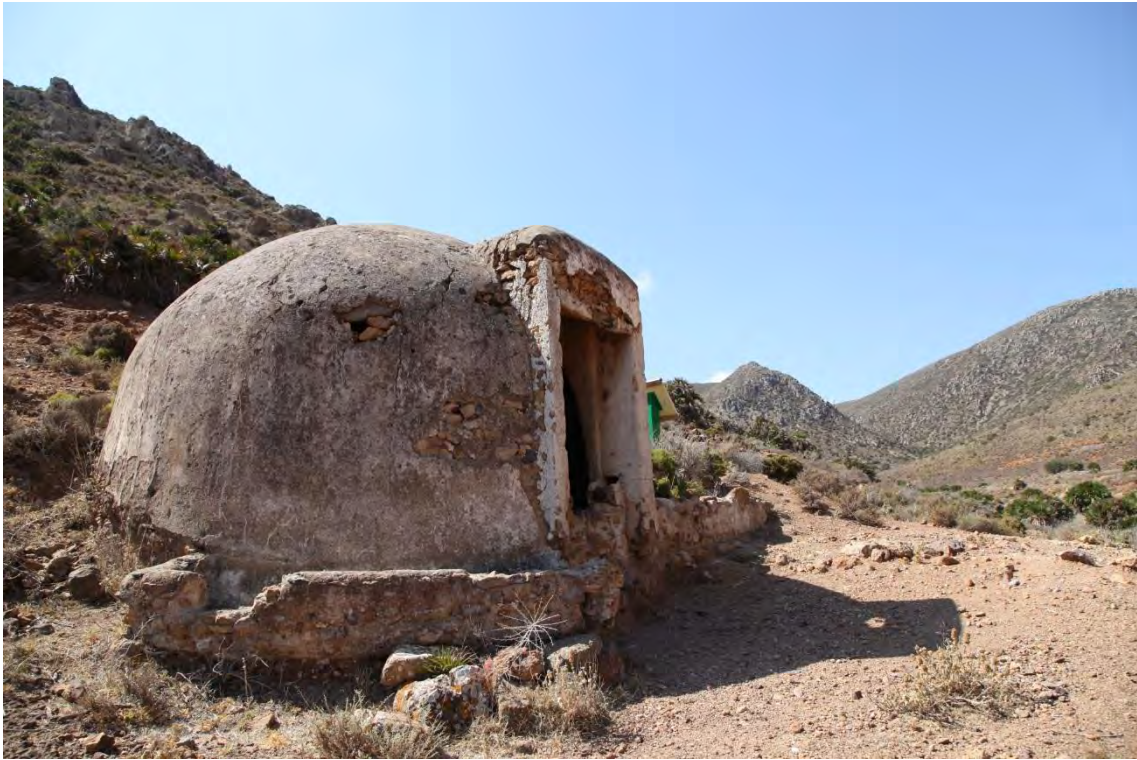
Fotografía 5.6.9: aljibe en cúpula del sendero (conocidos en la zona como tanques o estanques), del Sendero de Requena, con abrevadero
