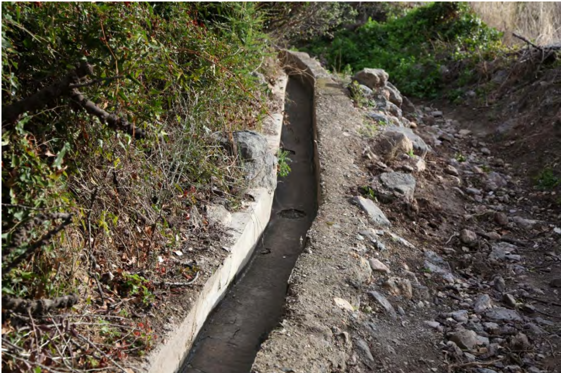
Fotografía 1.63: detalle de la acequia de El Marchal
