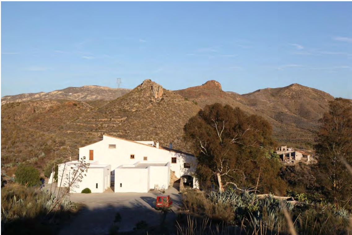
Fotografía 1.49: cortijo principal de doña Claudia Scholler, con mantenimiento, en la zona de El Saltador. Tiene una tipología híbrida en el mismo conjunto edificatorio (tejados en el cuerpo central y terraos en los añadidos)
