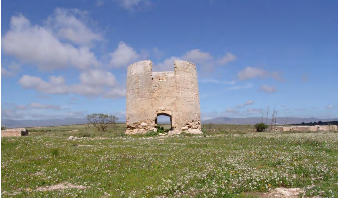
Fotografía 1.87: fachada oriental del molino de viento en estado ruinoso, con cuerpo casi cilíndrico sin escalonar, donde se observa las dos puertas y el hueco para la maquinaria, en Balsa Blanca (Parque Natural de Cabo de Gata-Níjar, Almería)
