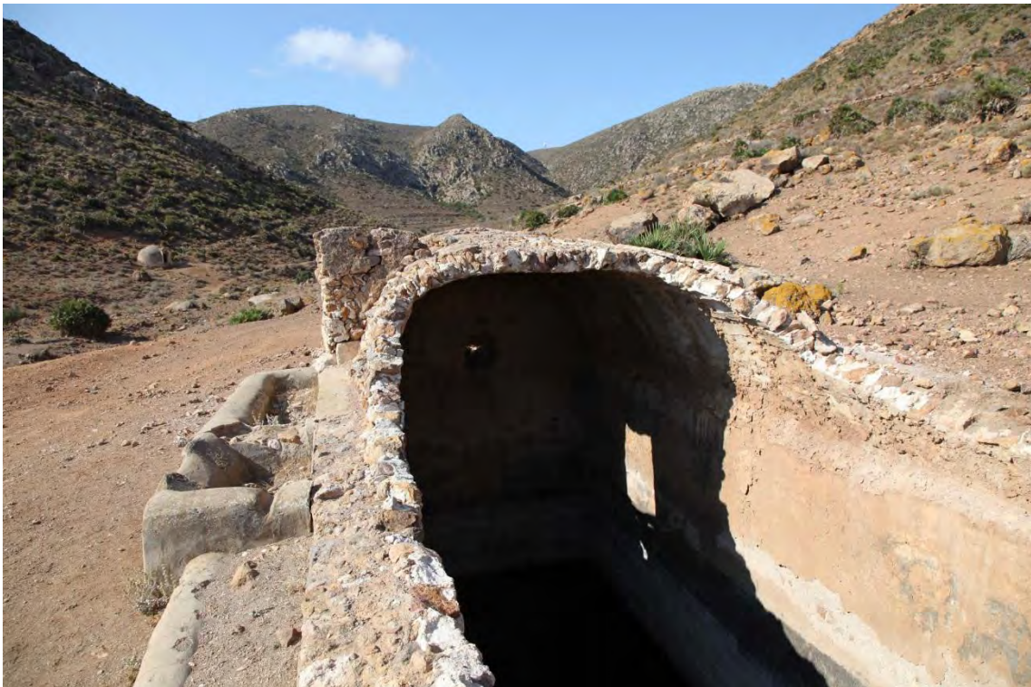
Fotografía 5.6.8: detalle de las piletas y de los abrevaderos del aljibe en bóveda de cañón, del Sendero de Requena
