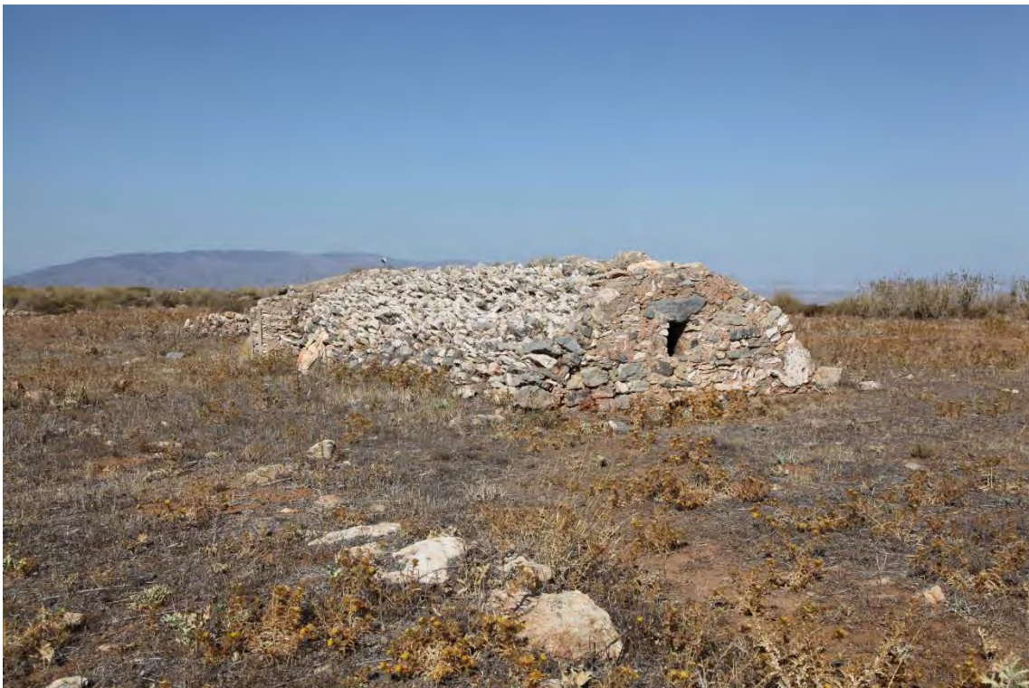
Fotografía 5.7.14: Aljibe Alto en la zona del Rincón de la Panocha, en la Sierra de Gádor entre Enix y Almería. Vista diagonal que permite la observación del ventanuco trasero de la bóveda de cañón
