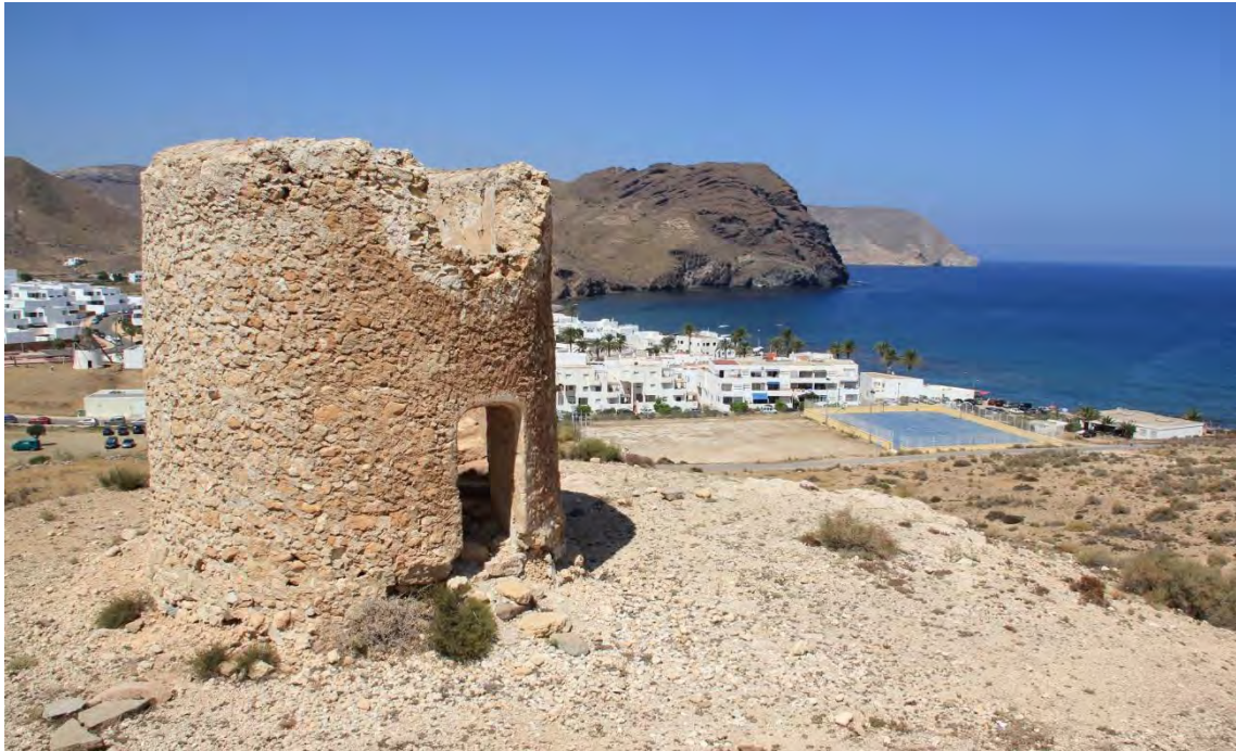
Fotografía 1.89: fachada meridional del molino de viento en estado ruinoso, con cuerpo cilíndrico sin escalonar y sin enlucir, donde se observa una de las dos puertas y el hueco para la maquinaria, en Las Negras (Parque Natural de Cabo de Gata-Níjar, Almería)
