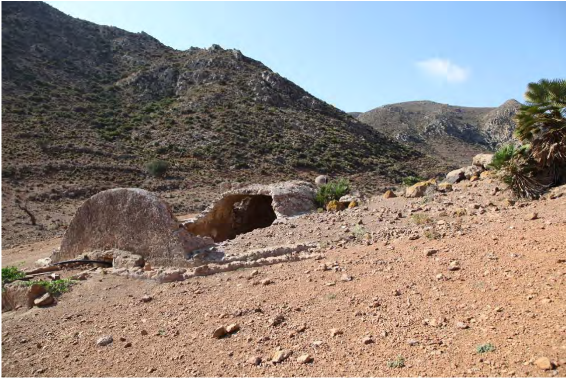
Fotografía 5.6.5: trasera del aljibe en bóveda de cañón, del Sendero de Requena, donde se aprecia el canal de captación y el decantador previo al depósito del aljibe
