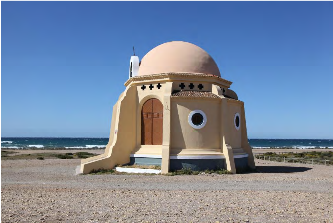
Fotografía 5.7.11: vista lateral de la ermita de la Virgen del Mar, en Torregarcía, que se encuentra en el extremo occidental del Parque Natural del Cabo de Gata-Níjar
