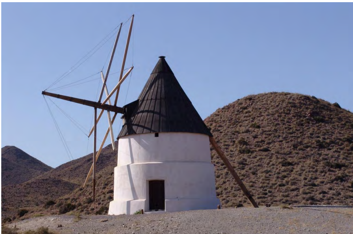
Fotografía 1.80: puerta meridional del molino de viento de chapitel móvil, con cuerpo tronco-cónico escalonado, en el Cerro del Avemaría, límite con el Campillo de Los Genoveses (Parque Natural de Cabo de Gata-Níjar, Almería)
