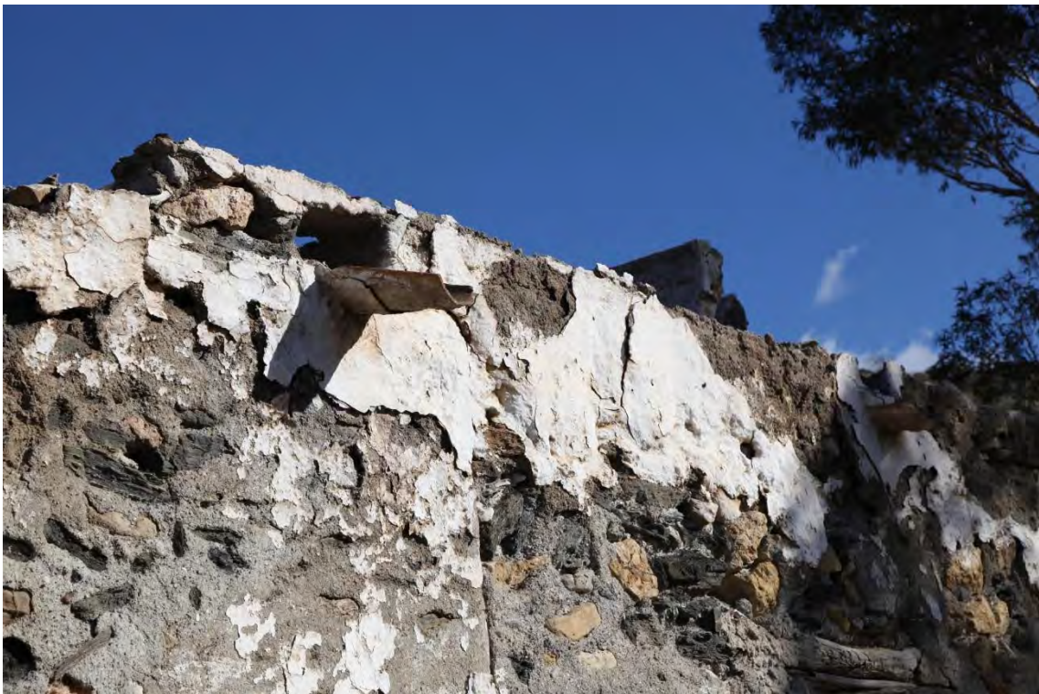
Fotografía 1.23: una de las canaletas del terrao , construidas con tejas rojas de arcilla cocida, de tipo árabe, del Cortijo Las Peñicas
