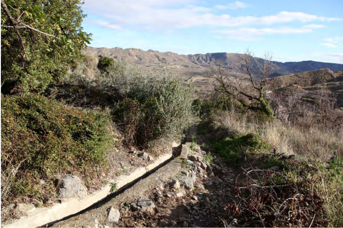
Fotografía 1.62: acequia de El Marchal. Como fondo escénico, se encuentra el límite septentrional del pre-Parque, establecido por la divisoria de aguas de Sierra Cabrera
