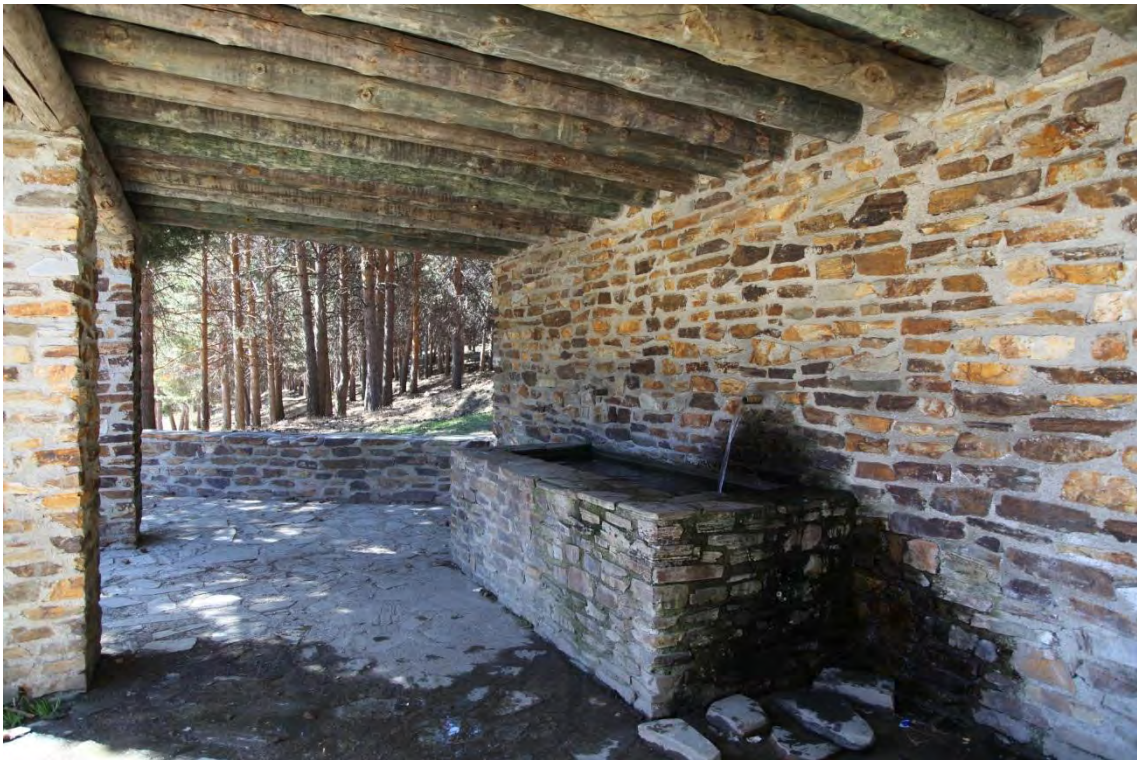
Fotografía 5.7.38: una de las fuentes-abrevadero del Puerto de La Ragua. El abrevadero es utilizado actualmente por los caballos que se encuentran en estado de semilibertad
