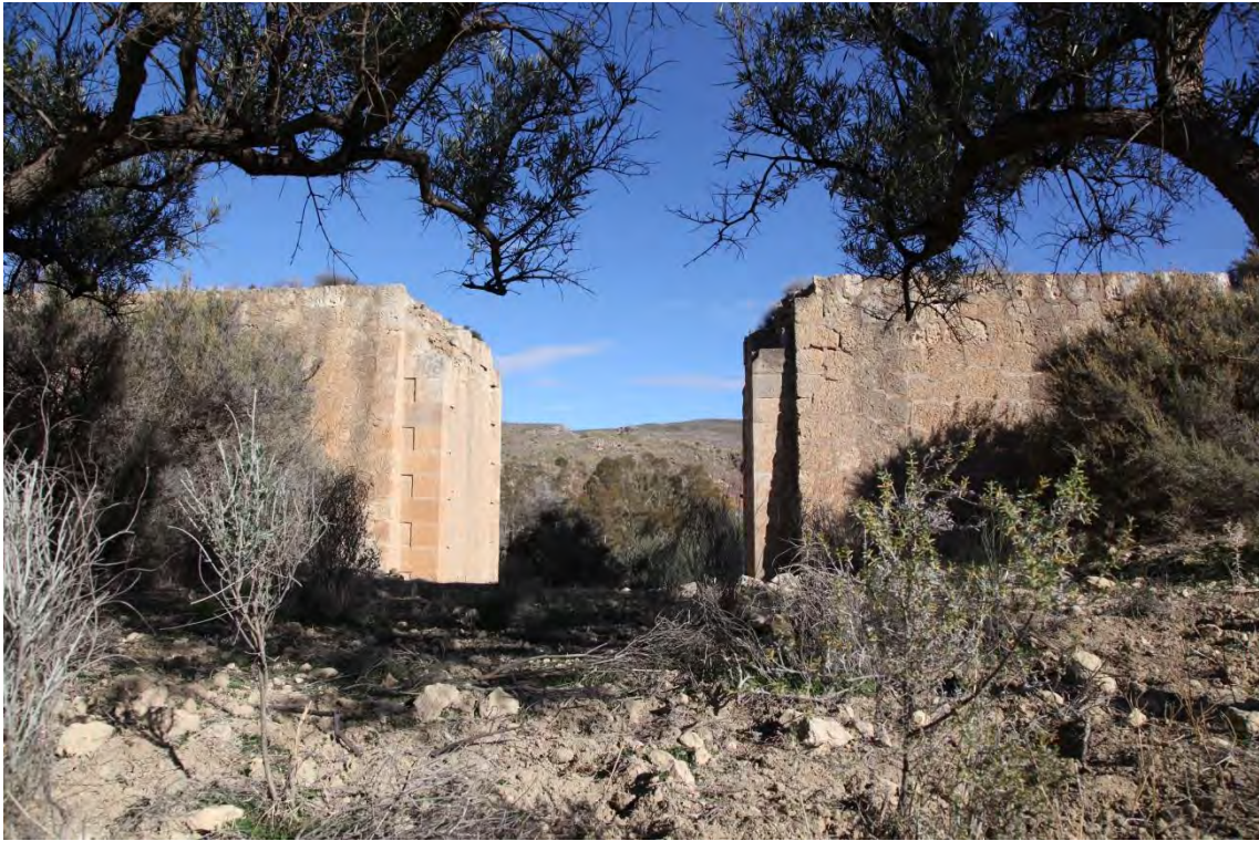
Fotografía 1.14: Puente de La Boquera (o de Los Arcos), del trazado del ferrocarril minero entre Lucainena de las Torres y Agua Amarga
