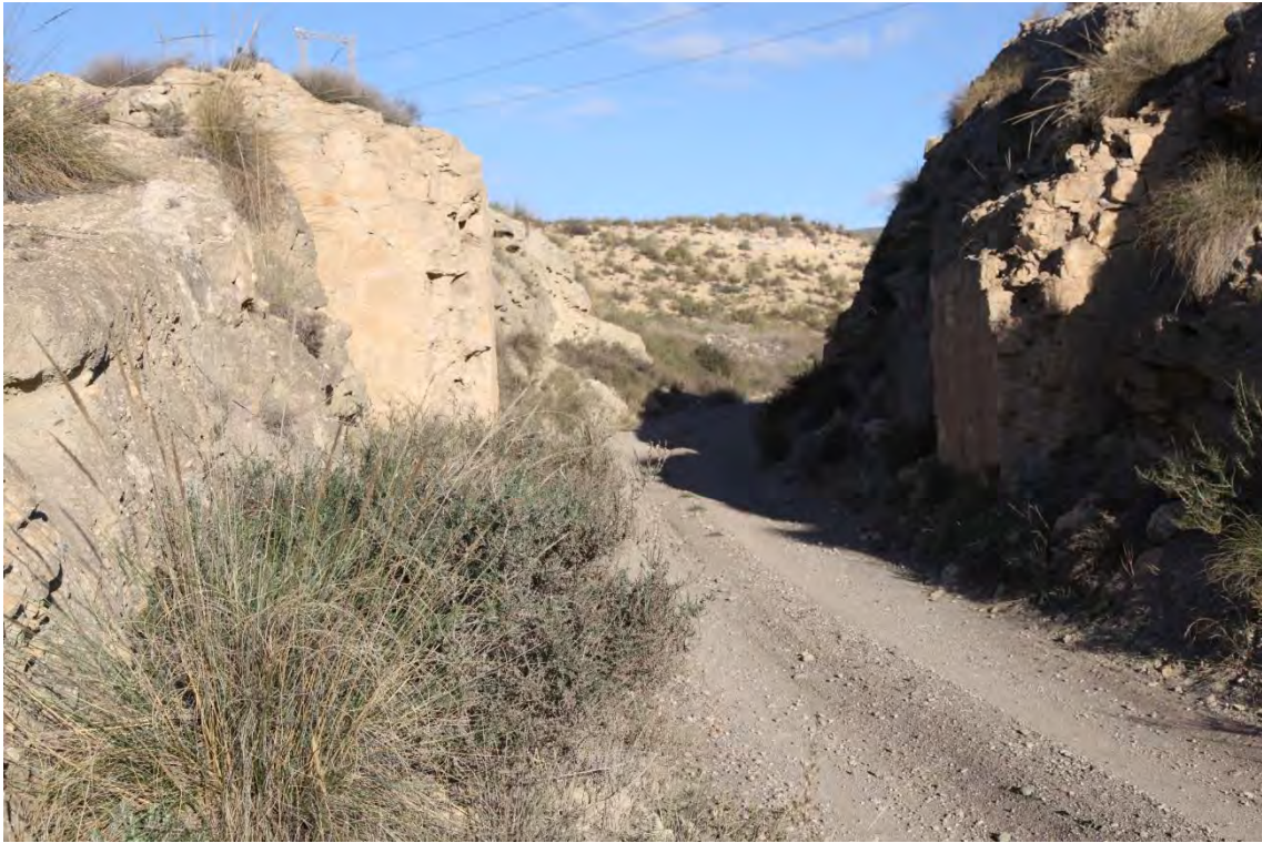
Fotografía 1.16: segundo paso elevado, desde el Puente El Molinillo hacia Agua Amarga, del ferrocarril minero
