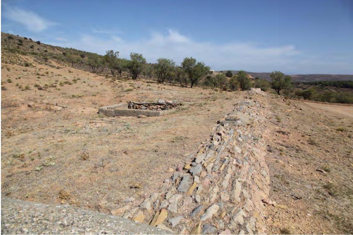
Fotografía 5.7.27: desde la torre de extracción y a la derecha de la imagen, se aprecia un murete de obra paralelo a la bóveda soterrada del aljibe de La Chanata. Este murete crea una pequeña depresión y retiene al agua de lluvia que baja encauzada por la ladera. El agua retenida entra al aljibe a través del decantador, donde se almacena. La boca del decantador se observa en la parte central de la imagen.
