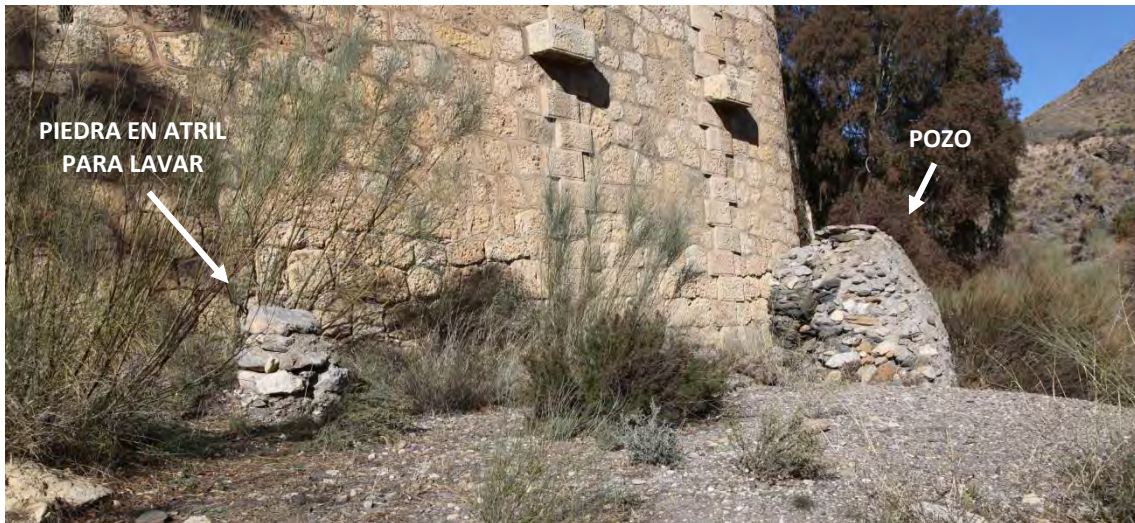
Fotografía 1.34: conjunto de piedra en atril para lavar y pozo, en las proximidades del Puente La Rafaela
