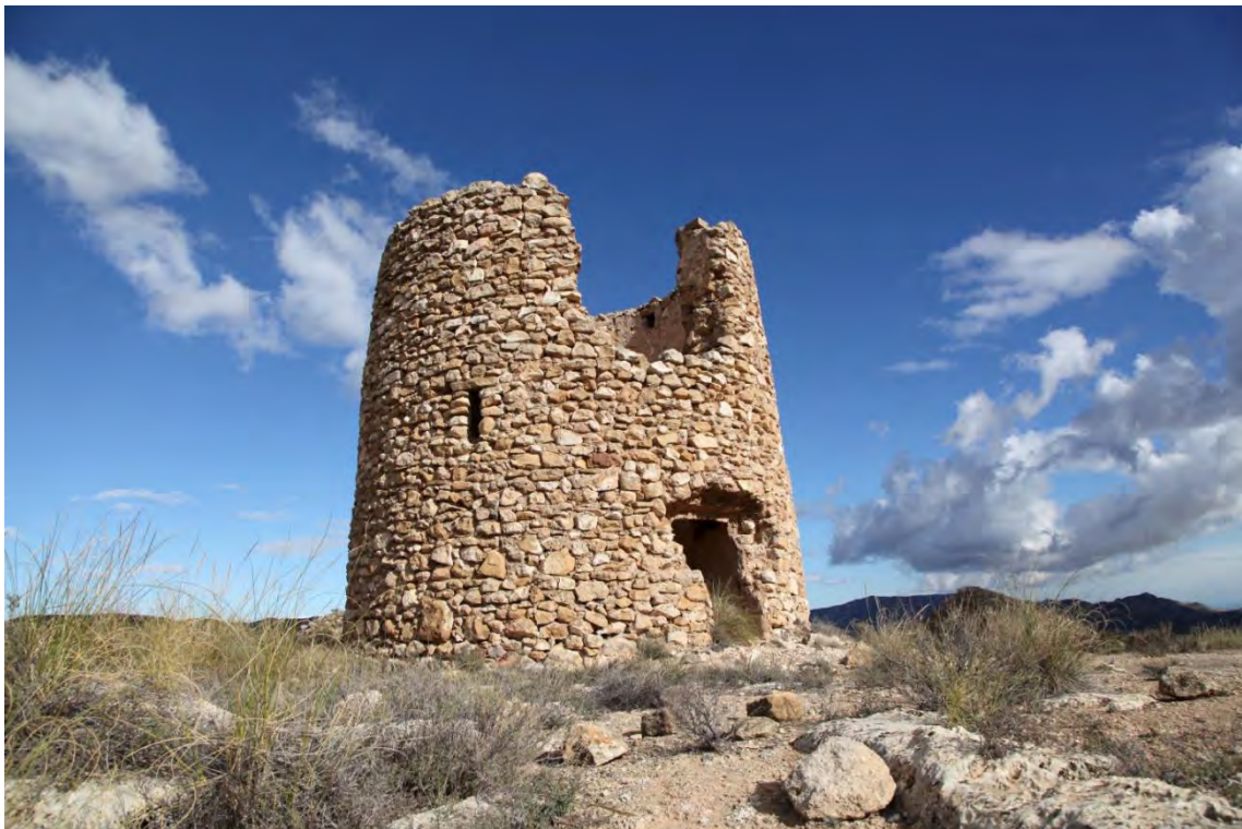
Fotografía 1.92: globo panorámico (para el disfrute de un paisaje sensorial) del Molino de Viento, observado hacia el norte (fachada sur), con el hueco superior para alojar la maquinaria de la molienda, en las proximidades del Pueblo de Lucainena de las Torres
