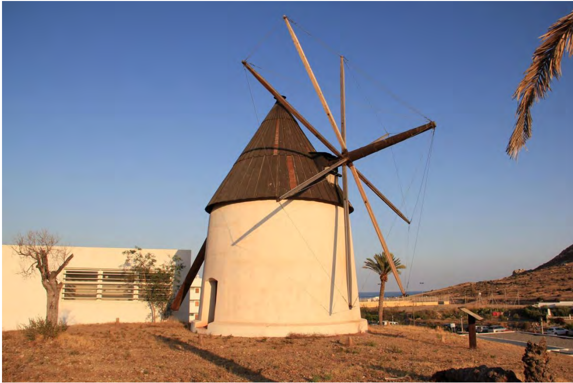
Fotografía 1.83: fachada occidental del molino de viento de chapitel móvil, con cuerpo tronco-cónico sin escalonar, en Las Negras (Parque Natural de Cabo de Gata-Níjar, Almería)
