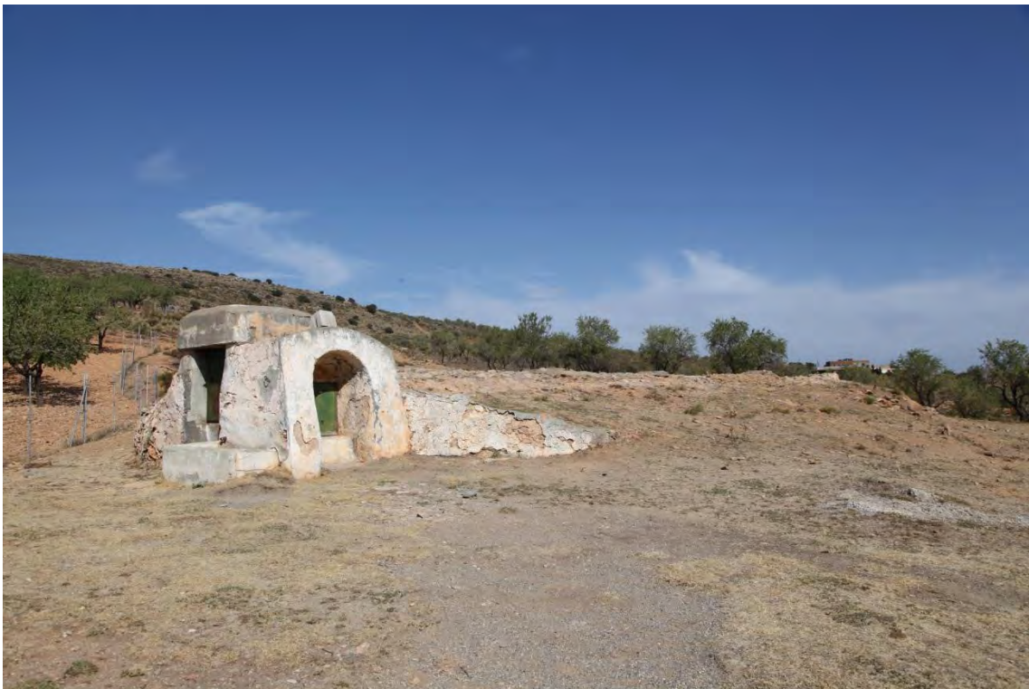
Fotografía 5.7.26: aljibe soterrado de La Chanata. Se observa la torreta de extracción, la poceta-abrevadero anexa a la torre de extracción, y un murete de obra paralelo a la bóveda soterrada de almacenamiento de agua
