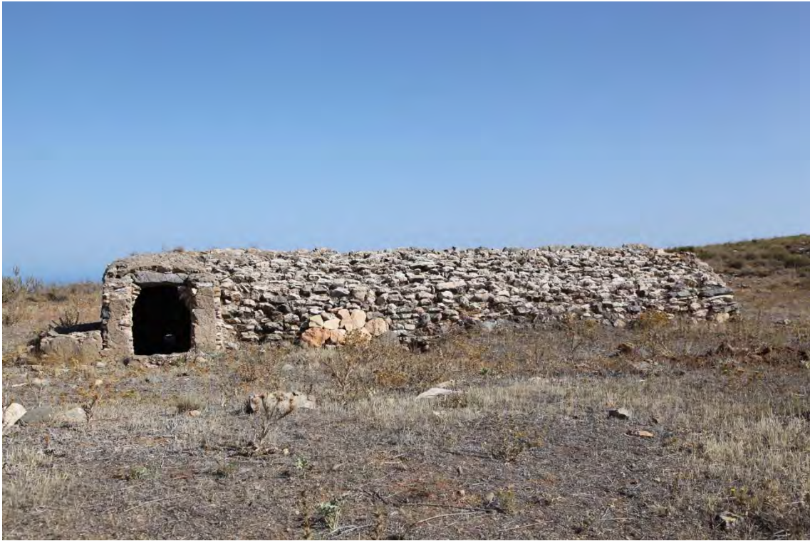
Fotografía 5.7.13: Aljibe Alto en la zona del Rincón de la Panocha, en la Sierra de Gádor entre Enix y Almería. Vista de la fachada longitudinal de la bóveda de cañón, donde se encuentra la entrada para la extracción de agua almacenada. Se observa, además, el abrevadero a la izquierda
