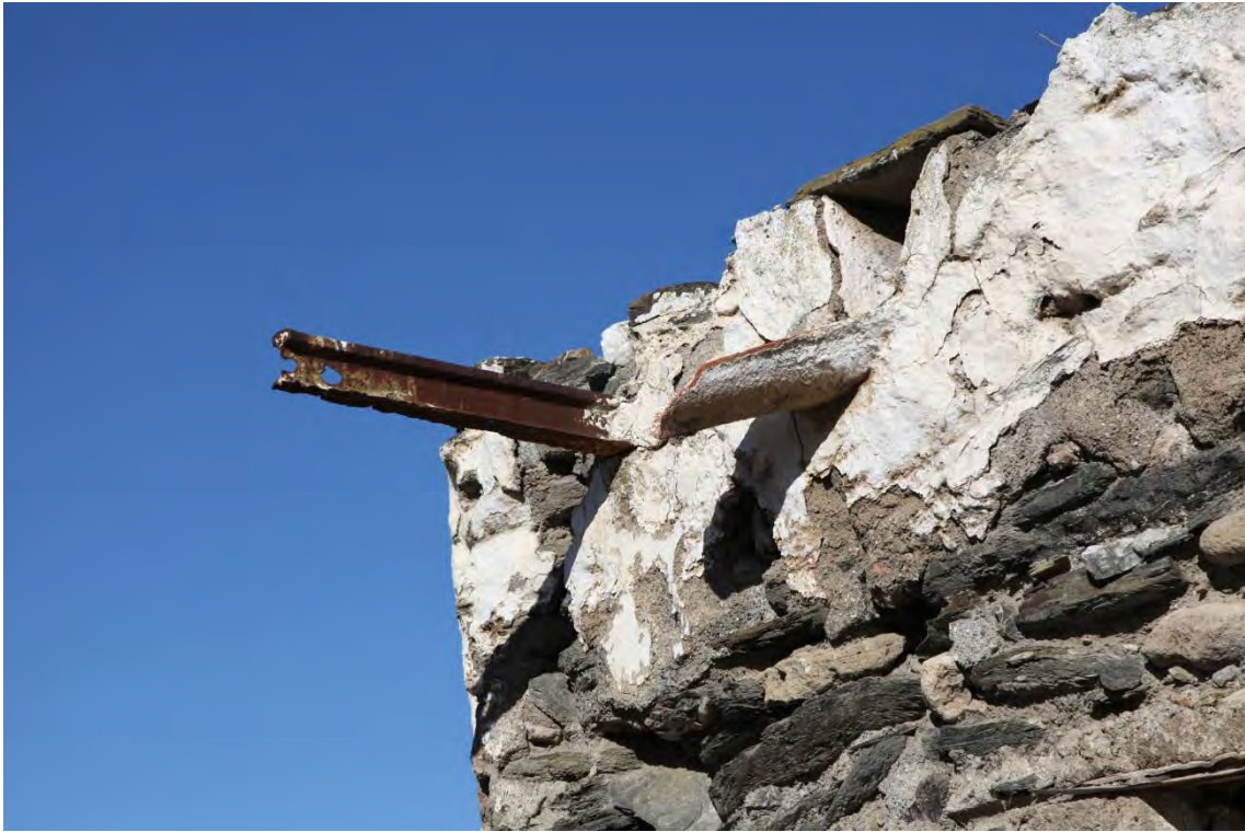
Fotografía 1.24: canaleta de teja roja de arcilla cocida, de tipo árabe, y raíl procedente del desmantelamiento del ferrocarril minero entre Lucainena de las Torres y Agua Amarga. El raíl se encuentra sobre el jaráiz , por encima del hueco donde se articulaba el palo que actuaba de palanca. Podía servir para la colocación de una polea en relación con el traslado de los serones llenos de pulpa de uva
