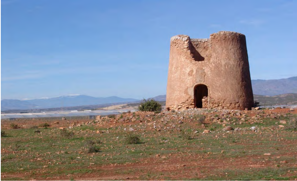
Fotografía 1.85: fachada sureste del molino de viento en estado ruinoso, con cuerpo tronco-cónico sin escalonar y enlucido, en la zona de El Nazareno (Parque Natural de Cabo de Gata-Níjar, Almería)
