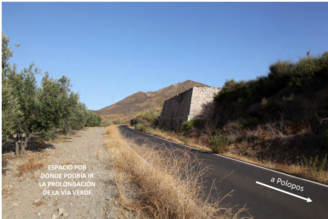
Fotografía 1.38: subestación de Peralejos, a unos 8 kilómetros desde el inicio en Lucainena de las Torres. Solo queda el depósito (estanque) de suministro de agua para las locomotoras. En el margen izquierdo de la fotografía, iría la caseta de la subestación, similar a la recreada en la fotografía de Gómez Martínez y Coves Navarro (2000). Por este margen izquierdo, y separada por balizas de troncos de madera, podría ir la prolongación de la Vía Verde
