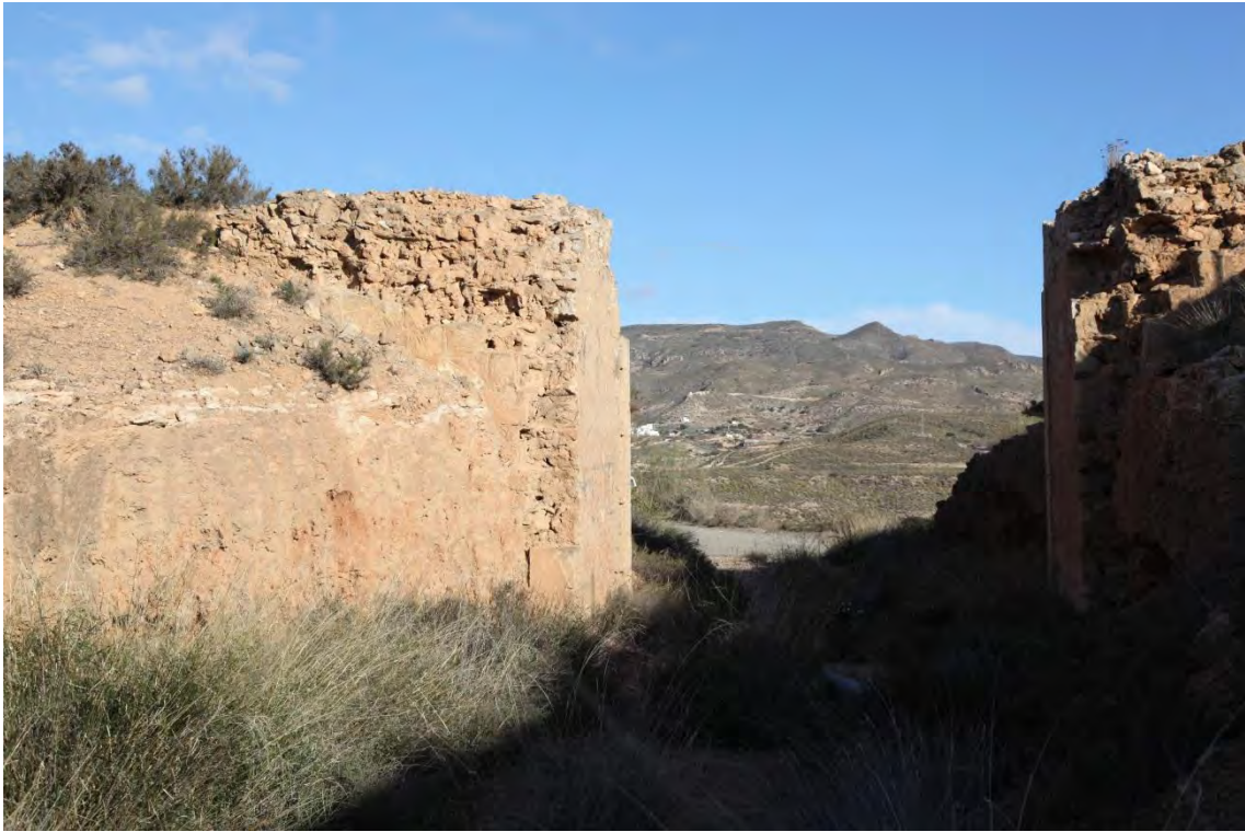
Fotografía 1.18: tercer paso elevado, desde el Puente El Molinillo hacia Agua Amarga, del ferrocarril minero
