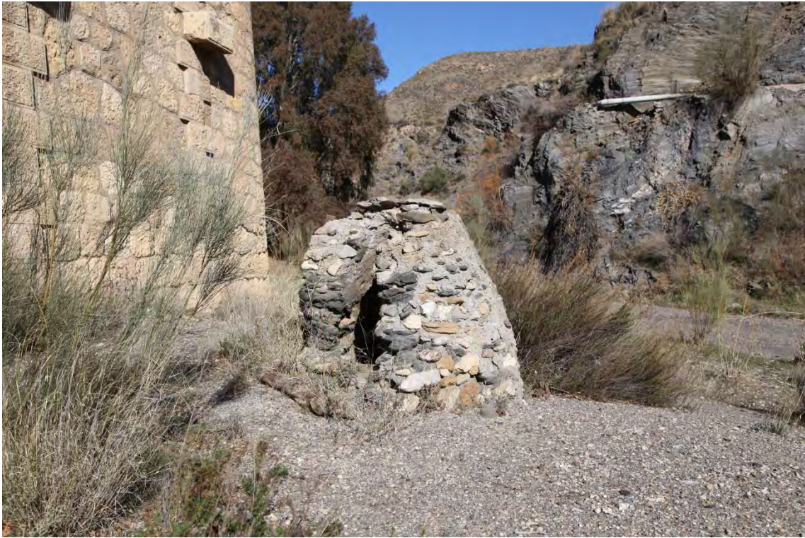
Fotografía 1.53: pozo en desuso junto a uno de los estribos del Puente La Rafaela
