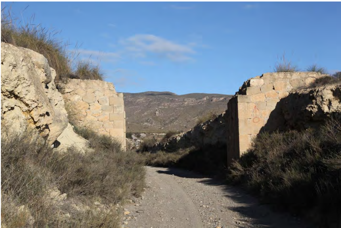
Fotografía 1.15: primer paso elevado, desde el Puente El Molinillo hacia Agua Amarga, del ferrocarril minero
