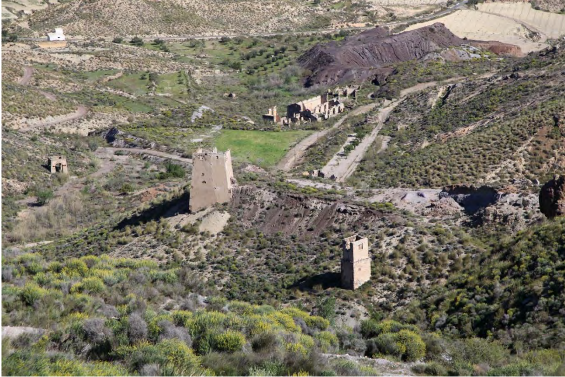
Fotografía 1.7: castillete rehabilitado como palomar, junto al respiradero del Socavón Colmenillas, cuyo plano inclinado estaba en cadena con el del castillete de la fotografía anterior. El plano inclinado del castillete rehabilitado enlazaba con el ferrocarril auxiliar del Hospital (comunicación personal de don Ramón Carreño Ayarza, del 3 de abril de 2014)
