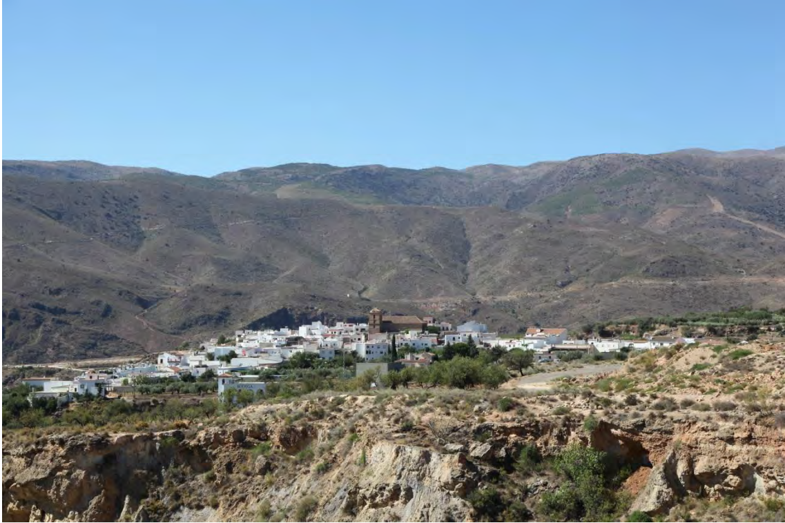
Fotografía 5.7.31: desde la carretera de Canjáyar a Fondón, se observa, en un primer plano, al Pueblo de Padules. Al pie del fondo escénico, y a la derecha del pueblo, se encuentra el trazado del Cordel de Cacín
