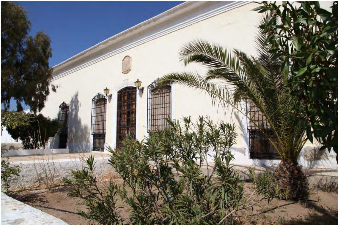
Fotografía 5.7.1 y 5.7.2: Panorámica y fachada principal del Cortijo El Romeral, en la Bahía de Los Genoveses (Parque Natural del Cabo de Gata-Níjar, Almería)
