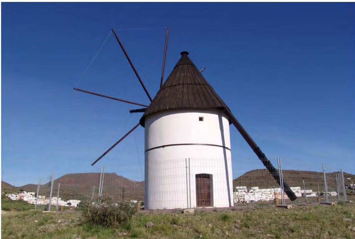
Fotografía 1.77 y 1.78: molino de viento de chapitel móvil, con cuerpo cilíndrico, y con la puerta occidental bajo las aspas (fijas tras la restauración), y la oriental junto al timón, entre el Pozo de Los Frailes y San José (Parque Natural de Cabo de Gata-Níjar, Almería)
