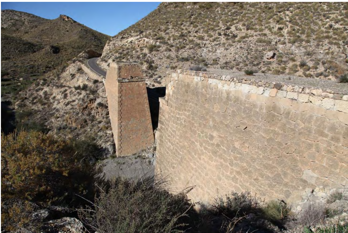
Fotografía 1.9: Puente El Molinillo, visto hacia Lucainena de las Torres, construido para que el ferrocarril minero cruzara el Río Alías
