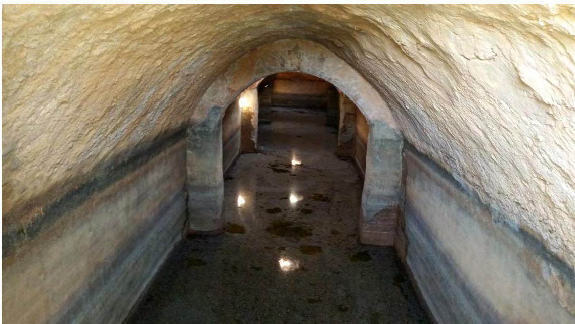
Fotografía 5.7.28: interior del aljibe. En las paredes de la bóveda soterrada quedan marcados los niveles del agua almacenada
