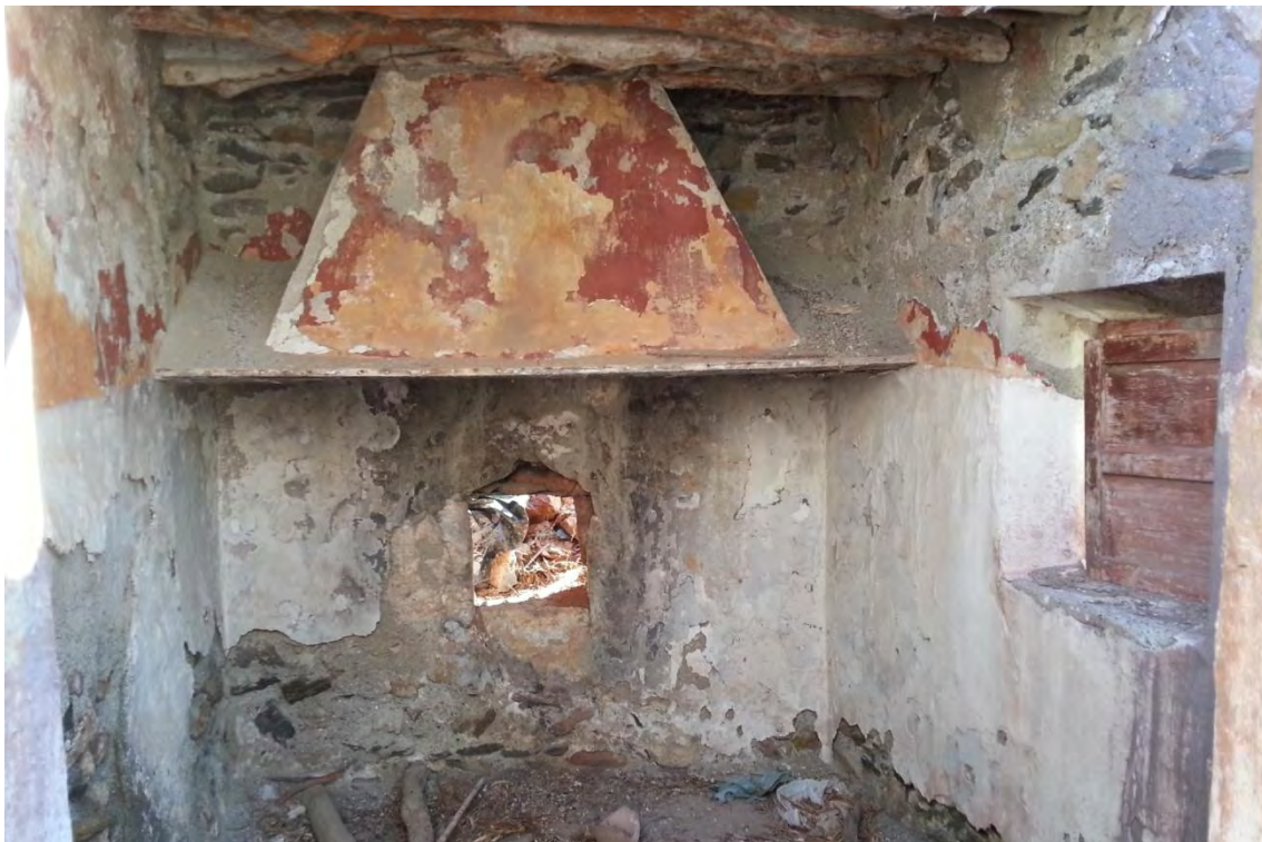
Fotografía 1.27: caramachón del cuarto del horno, que se accede desde el porche del Cortijo Las Peñicas
