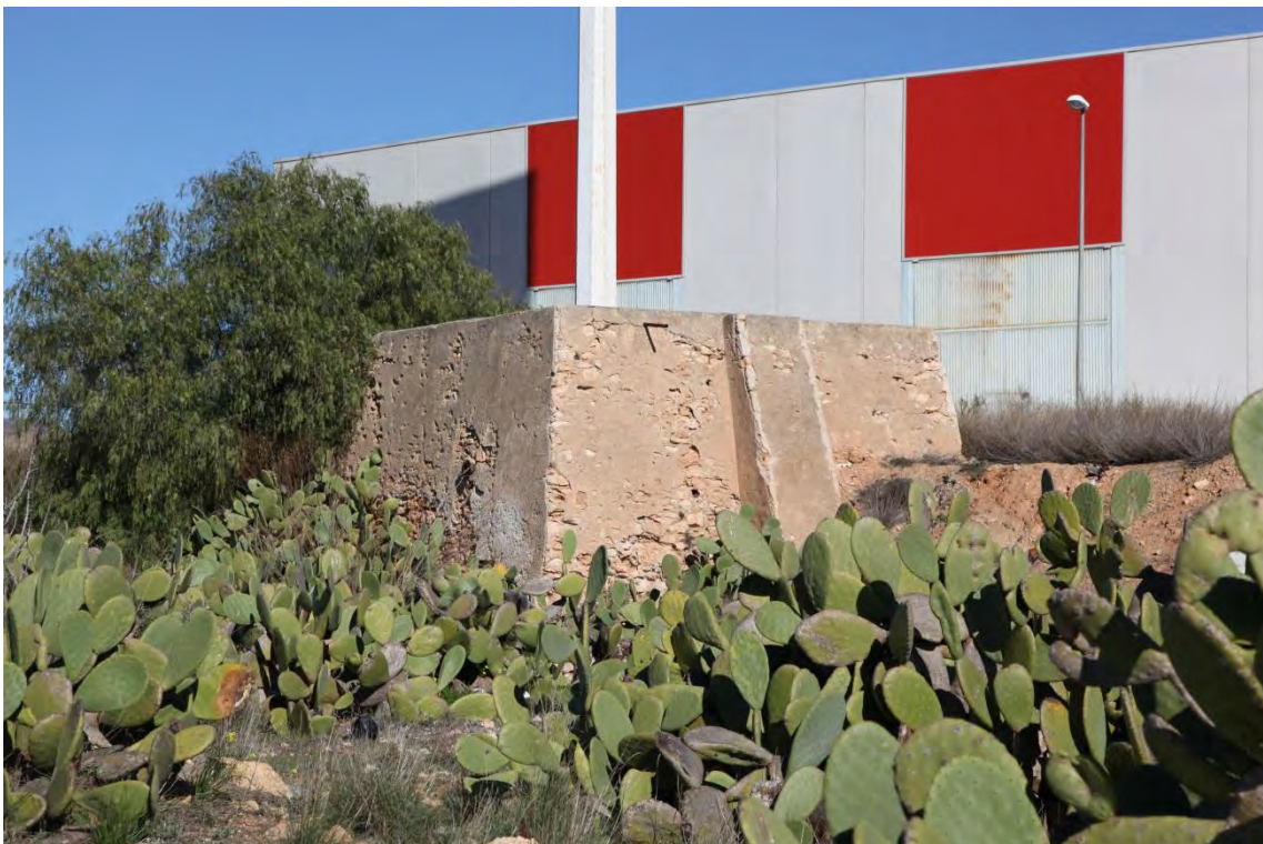
Fotografía 1.19: estanque de la sub-estación Camarillas, en la zona de Venta del Pobre, del ferrocarril minero entre Lucainena de las Torres y Agua Amarga
