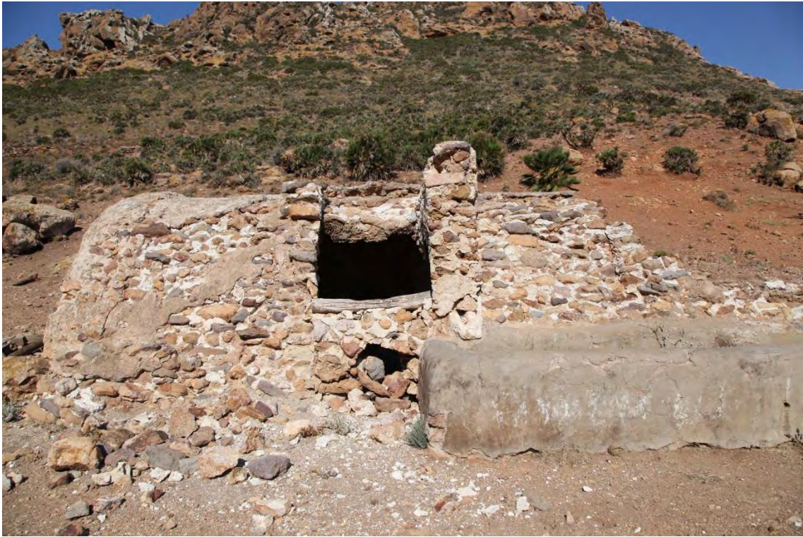
Fotografía 5.6.7: ventana de extracción del aljibe en bóveda de cañón, del Sendero de Requena. Se aprecia la canaleta que conducía el agua al primer abrevadero
